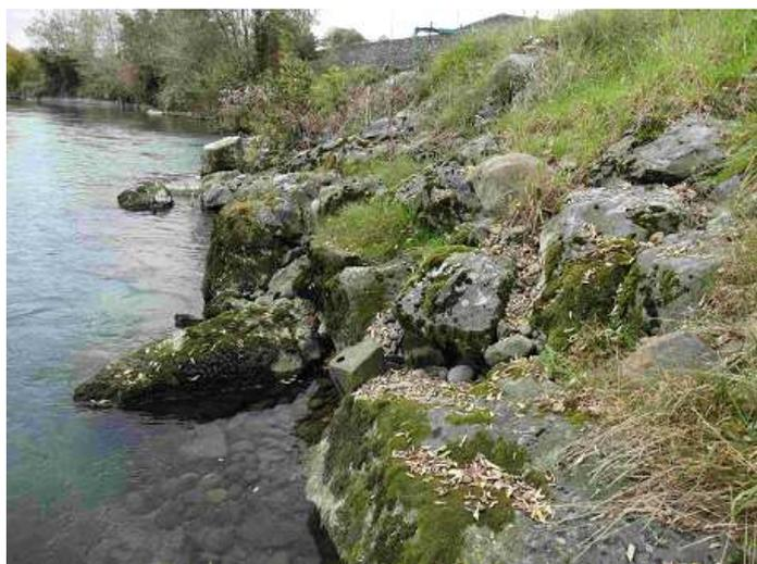
*Figure 49: Enrochements de la surverse et début de la mouille en RD (Oct. 2015)*
