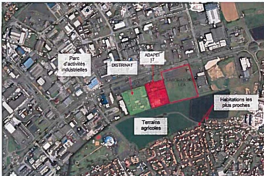
Figure 2 : Vue aérienne du site LEA NATURE
