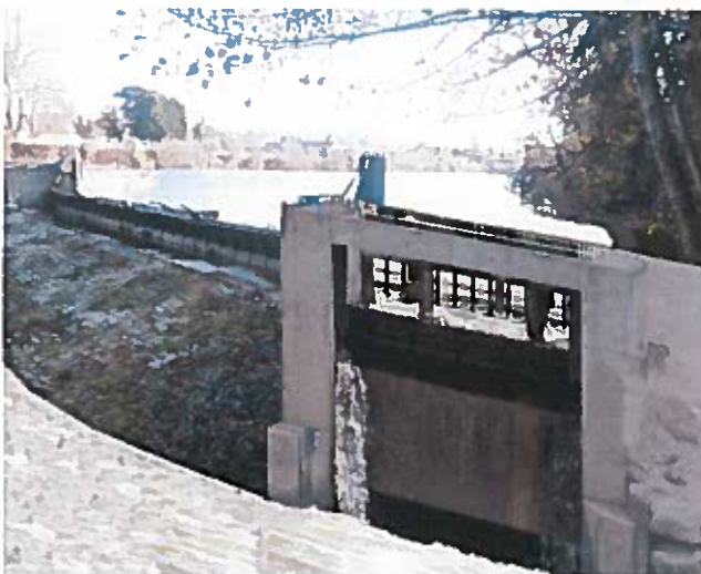
Figure 9 : Photomontage de la VLH intégrée entre les deux bajoyers gauches du seuil de Buxeuil
