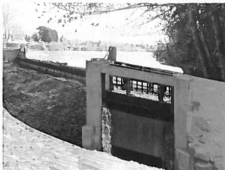
Figure 1 : Photomontage de l'intégration de la VLH entre les deux bajoyers à l'extrémité gauche du seuil de Buxeuil.
