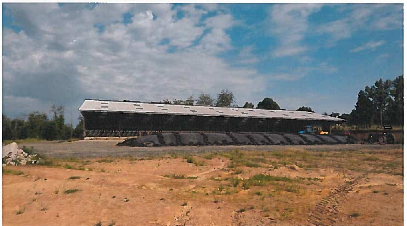
Photo 1 : Bâtiment agricole récemment construit (source : CDA 19)
