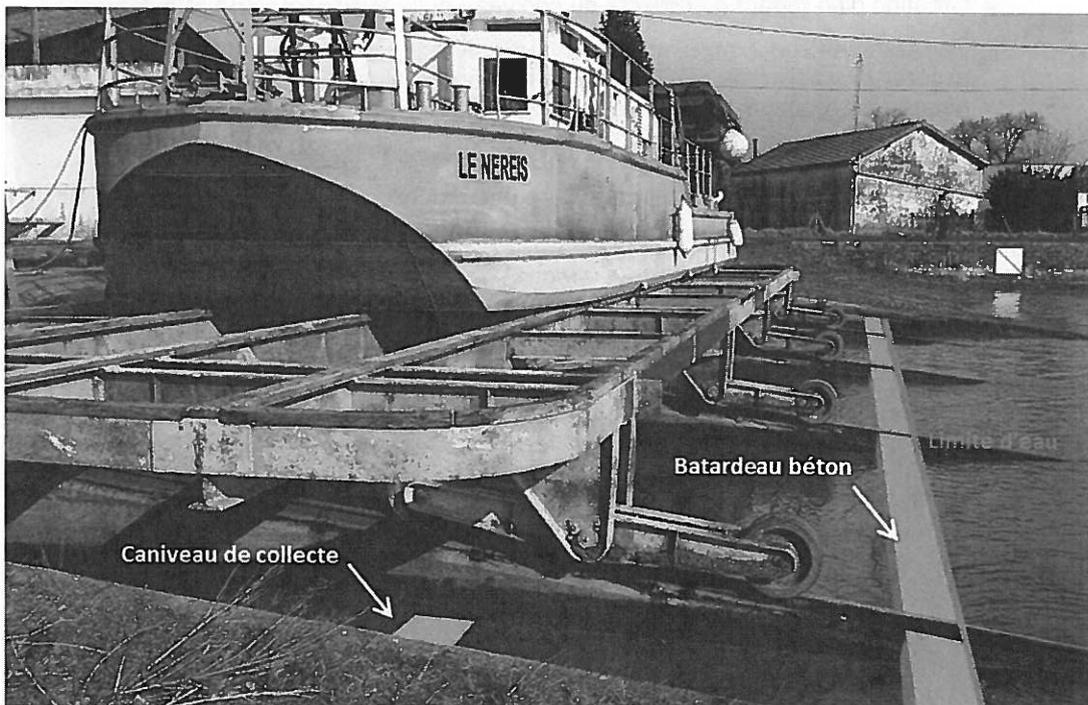
Figure: Scénario - Adaptation possible vis à vis de la submersion du redan inférieur
