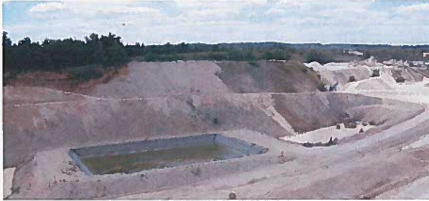
Récupération des eaux pluviales dans un bassin étanche pompé pour alimenter les sprinklers du site
