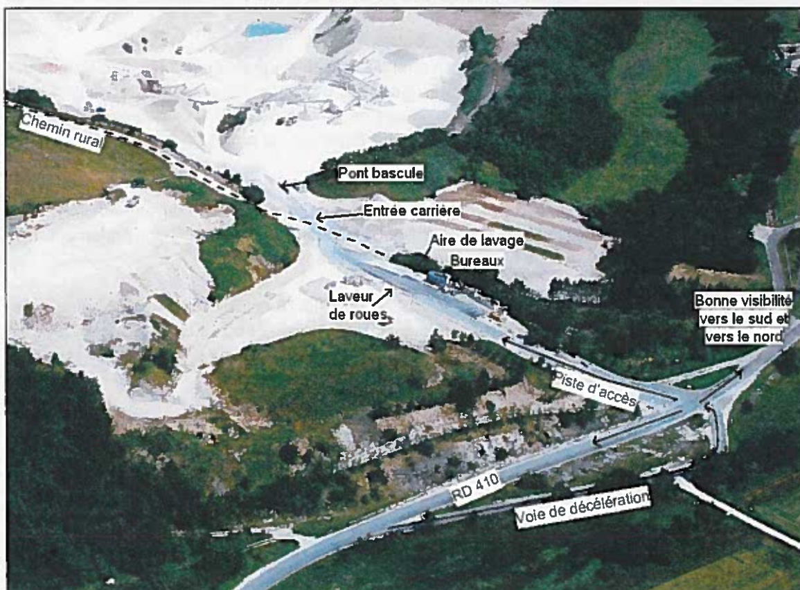
Figure 27 : Vue aérienne des aménagements d'accès au site
