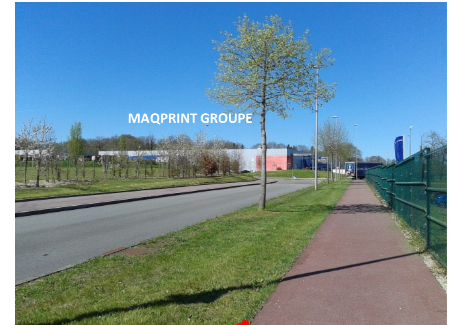
Vue sur bâtiment MAQPRINT GROUPE Depuis rue Amédée Gordini
