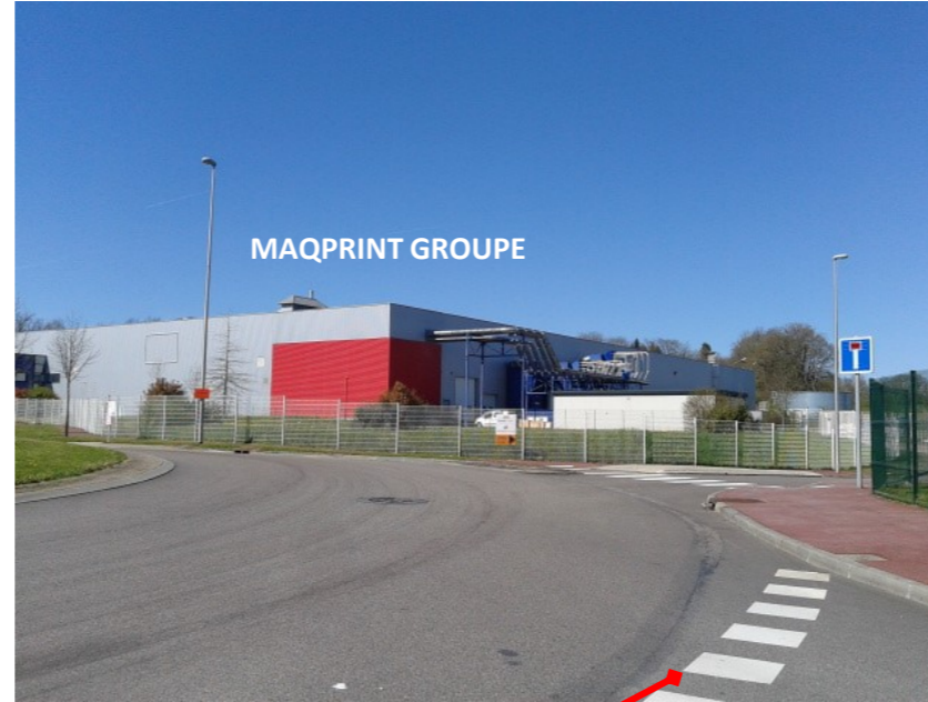
Vue sur bâtiment MAQPRINT GROUPE Depuis rond point rue Amédée Gordini
