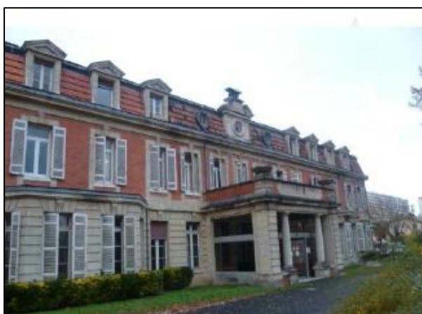
Façade de l'horloge
