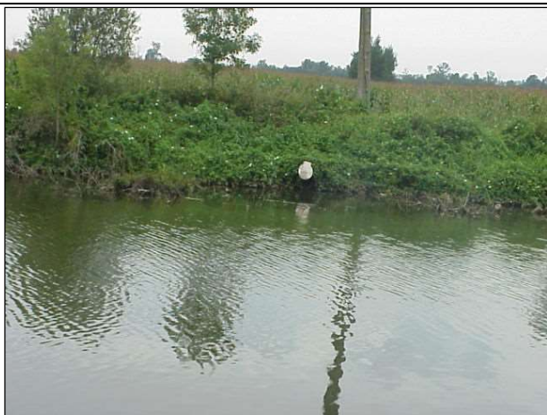
Digue peu entretenue, rejet de drainage des cultures vers la Vendée en rive droite au niveau de la Joyeuse
