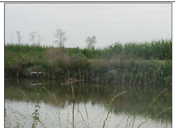
Exemple de mauvais aménagement par- Pieux battus et grillage en aval de la Hutte du Gros Vergne,
