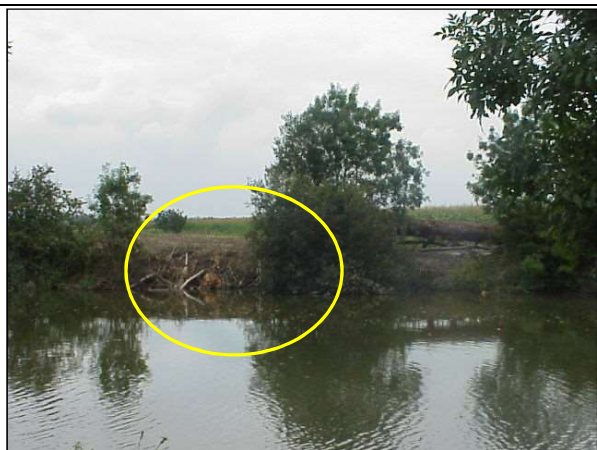
Problème d'érosion de berge et de rémanents en aval de Velluire
