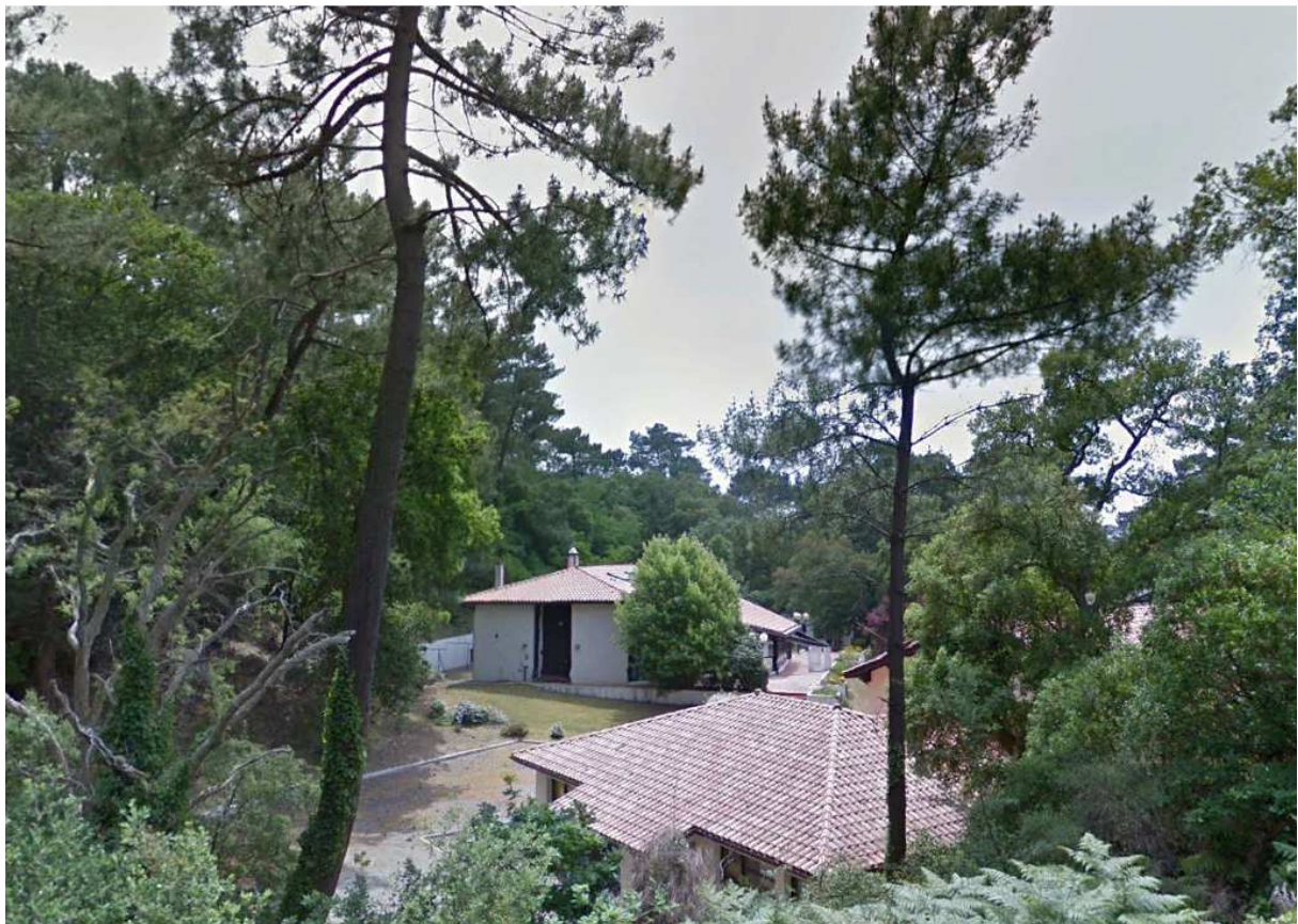
Figure 9 : Vue de la colonie de vacances existante depuis l'angle nord-est
