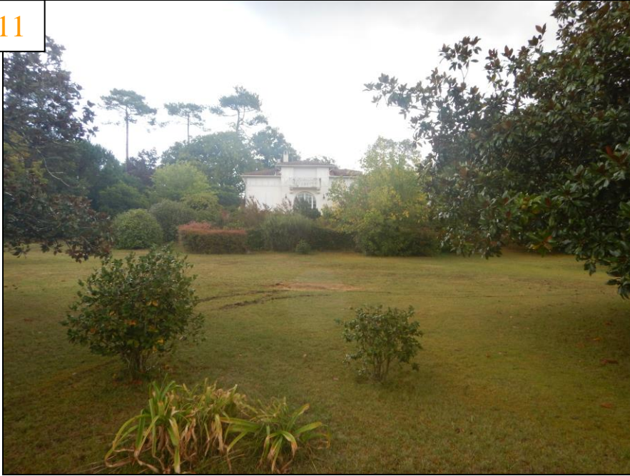
Vue sur la propriété et le parc urbain
