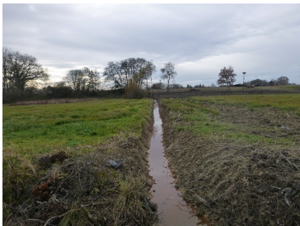
Fossé de drainage sur l'Estey à Yzosse
