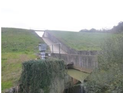
Retenue Collinaire sur le Gioulé
