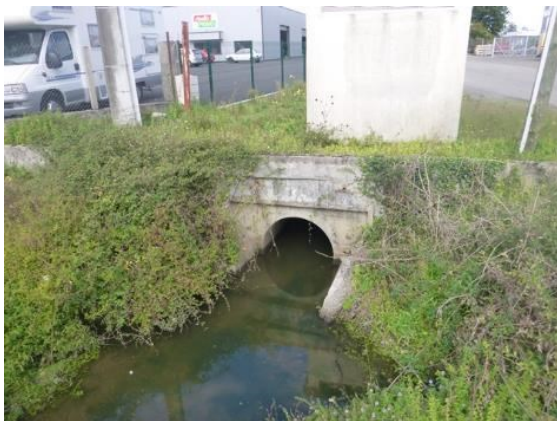
Le ruisseau du Péré à Bas-Mauco. A gauche, un busage du lit mineur sur environ 120 m provoque une mise en charge du cours d'eau en amont, à droite.
