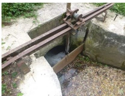
Vannes levantes sur le ruisseau de l'Ouzenté
