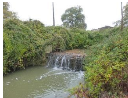
Déversoir sur le ruisseau du Gioulé
