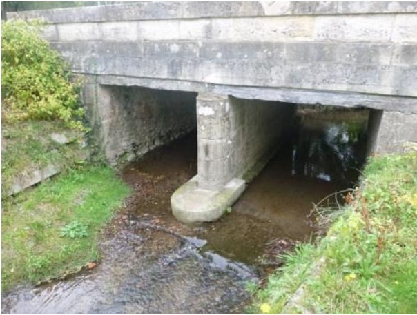
Radier de pont avec hauteur d'eau limitante sur le Moulin de Bordes à Souprosse
