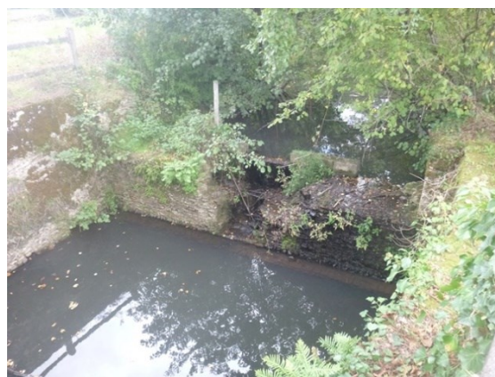
Seuil en rivière sur le ruisseau du Courdaoute
