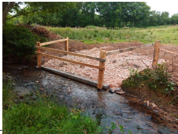
Descente aménagée clôturée (Source SIAD)
