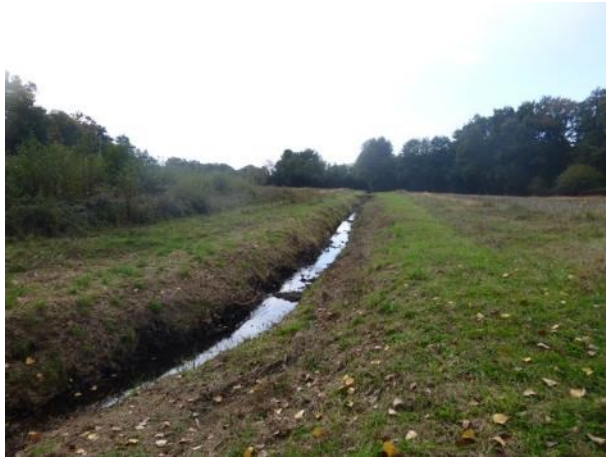
Lit récalibré sur le Lacaou à Le Vignau
