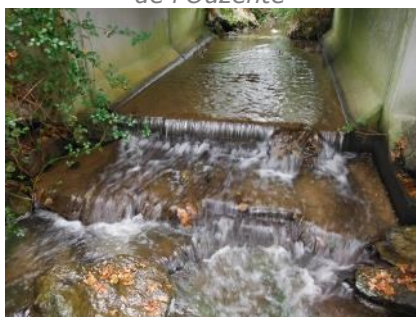
Radier de pont sur le ruisseau de Pont Neuf
