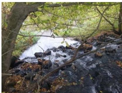
Enrochements sur le ruisseau du Martinet
