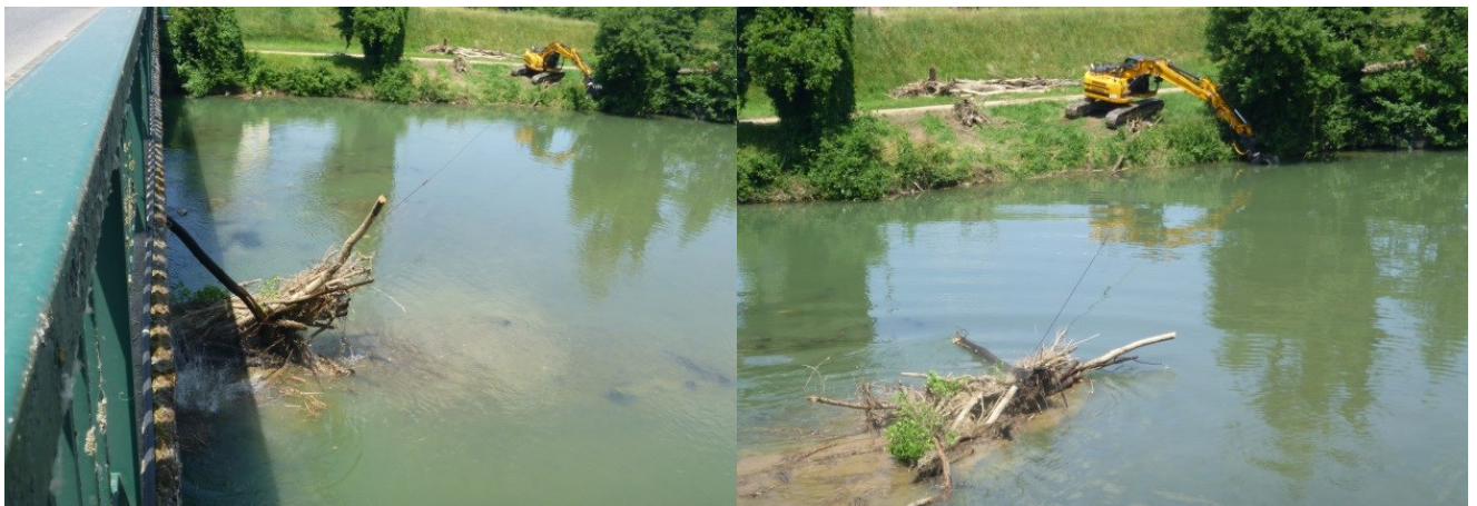
Retrait d'embâcles sur l'Adour, à proximité d'un pont
