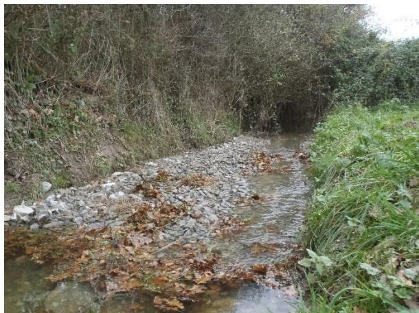
Exemple de recharge en dôme menée sur des cours d'eau du bassin versant de l'Isac (44)
