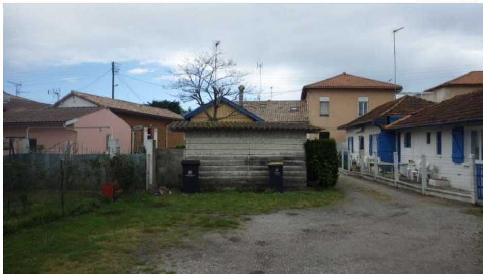
Photographie des bâtiments, remblais et dalle béton (Crédits CERAG – 09/05/2016)
