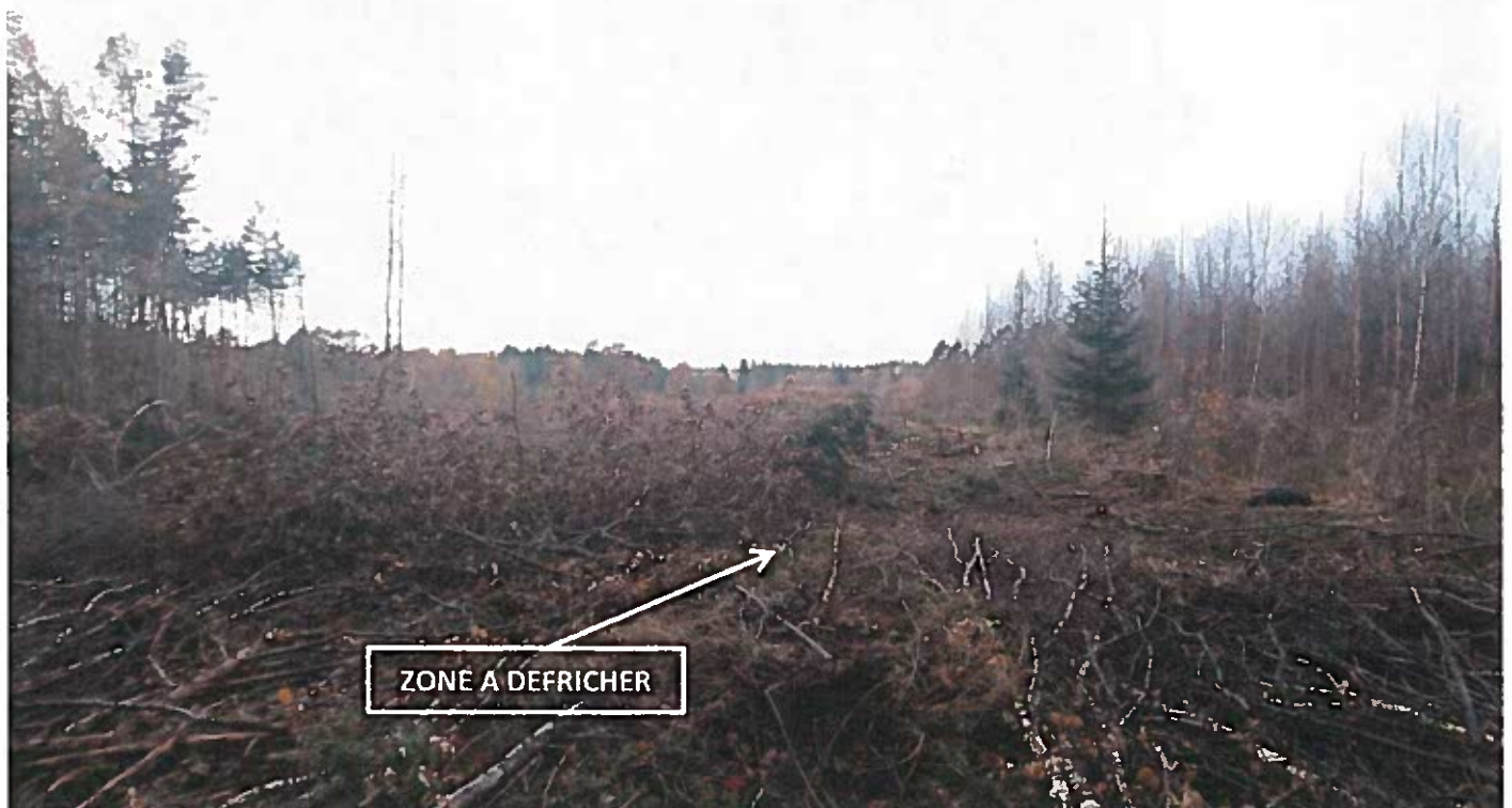
Photo 1 : Zone à défricher, parcelle C 43 (source : CDA 19)
