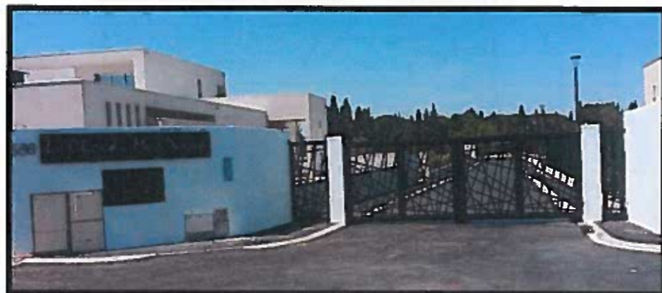
Portail électrique coulissant
