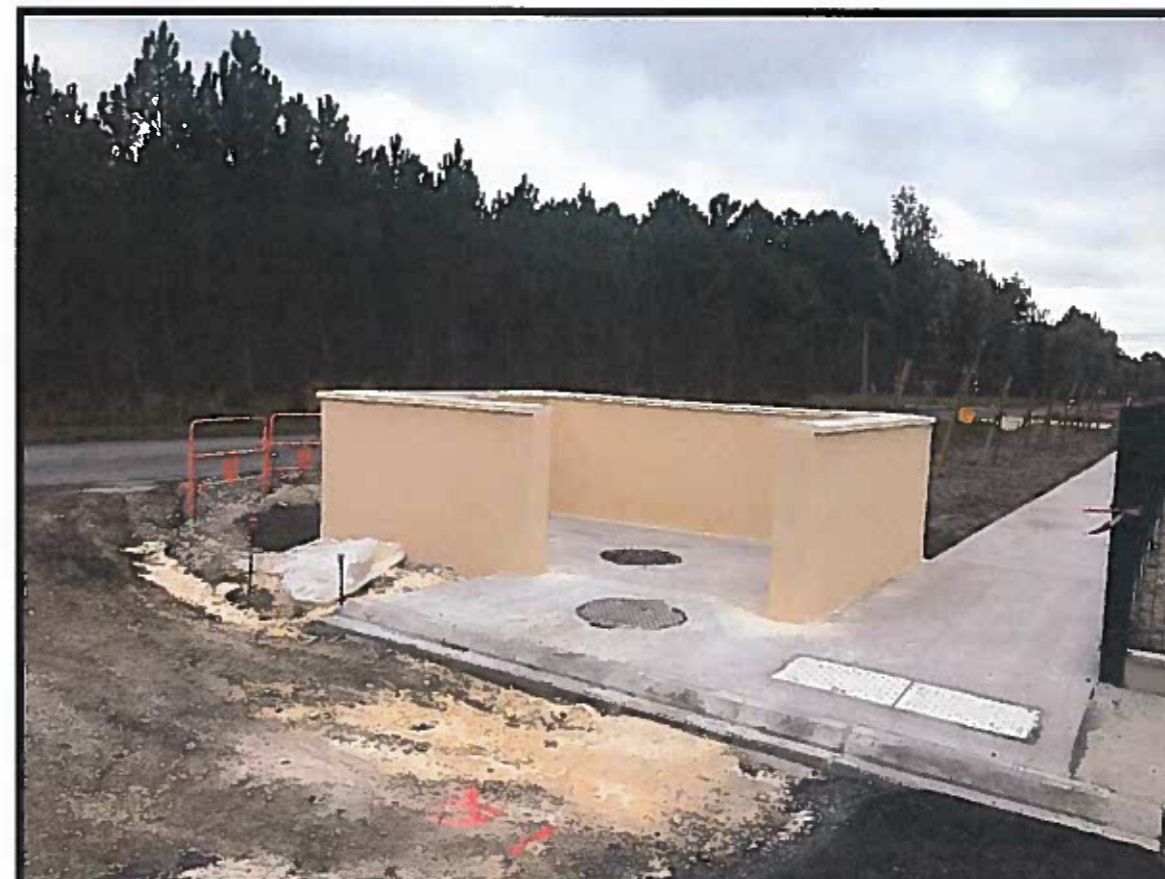
Aire de stockage des ordures ménagères en ciment
