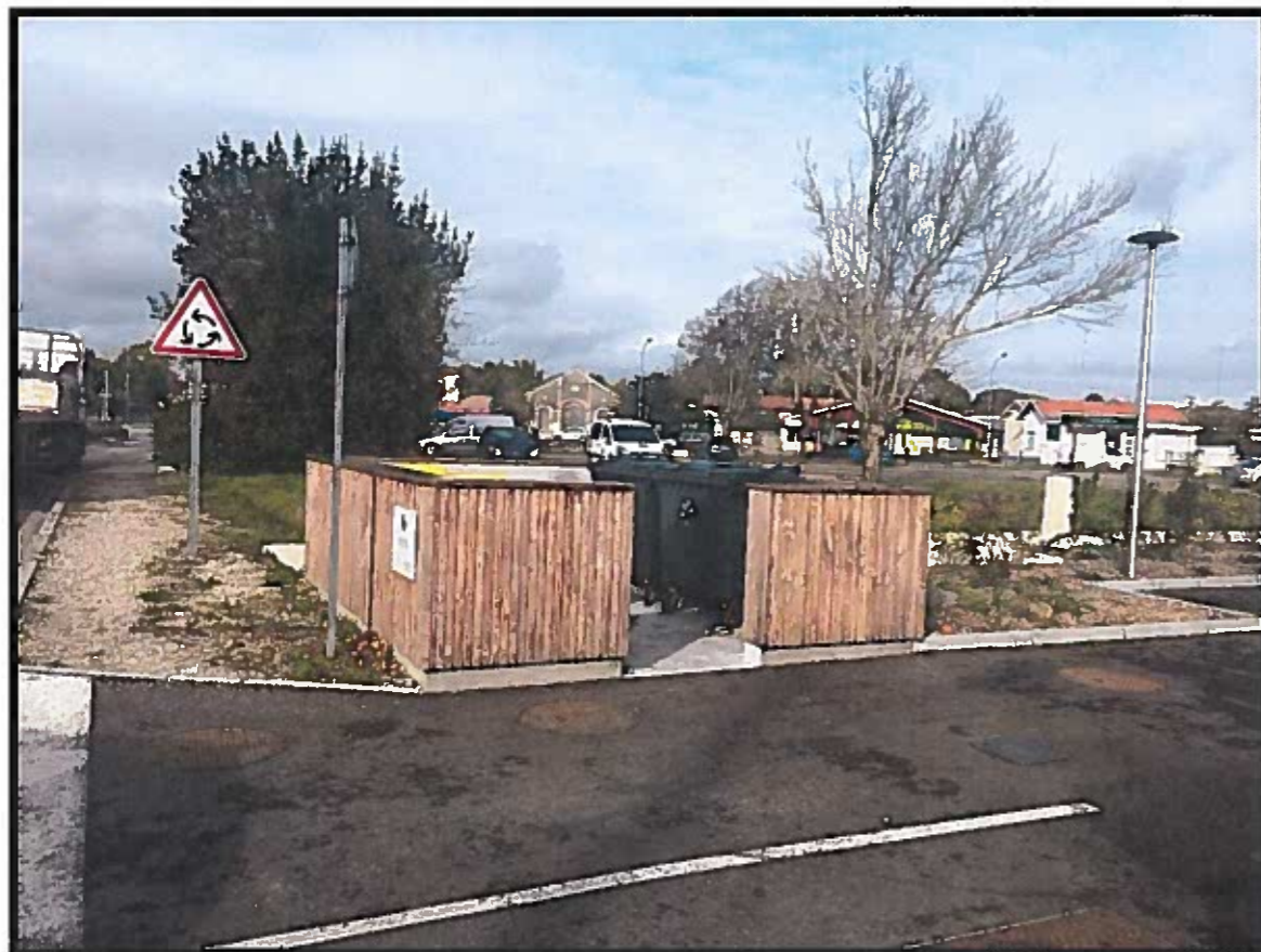
Aire de stockage des ordures ménagères en bardage bois
