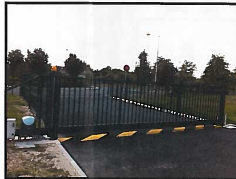
Portail électrique coulissant
