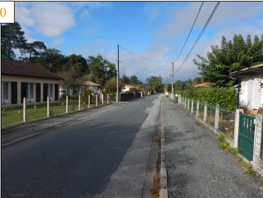
Vue sur la Route de l'Eglise au sud du projet
