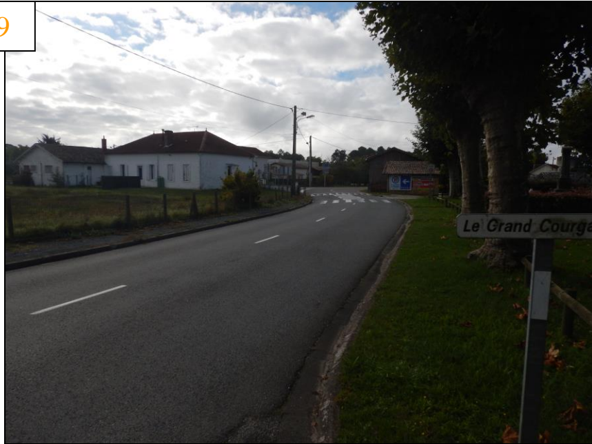
Vue sur l'avenue de l'Océan en direction du sud
