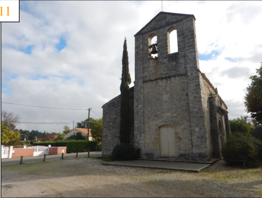
Vue sur l'Eglise de Saumos au sud du projet
