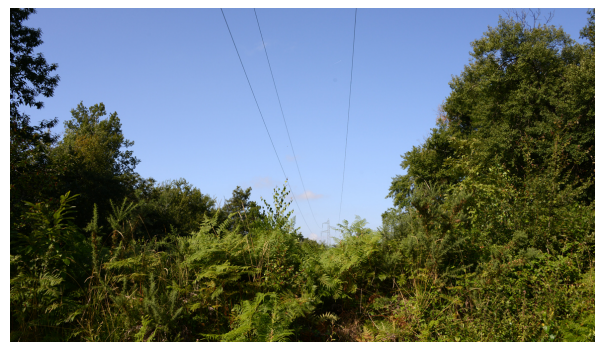
Bande pare-feu (état développé de la végétation)
