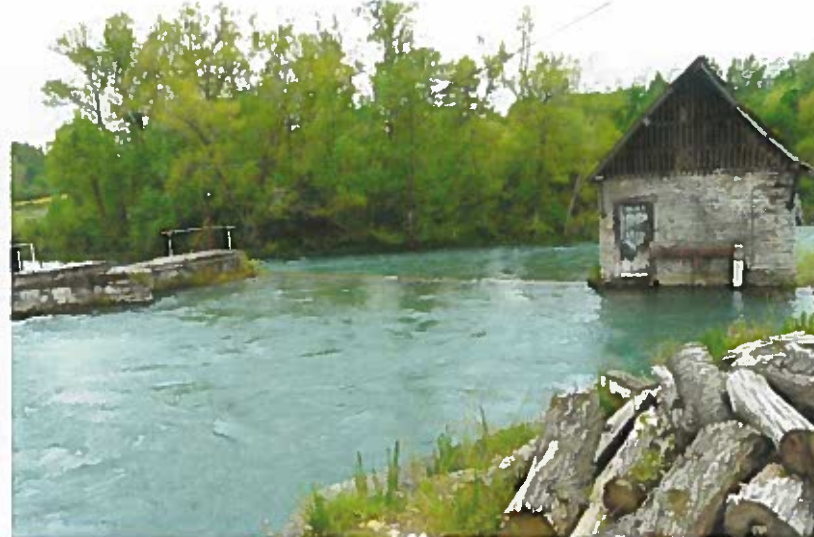
Figure 7 - Photographie 5 – Amont du canal d'amenée et petit moulin, depuis la rive droite du canal d'amenée – mai 2013
