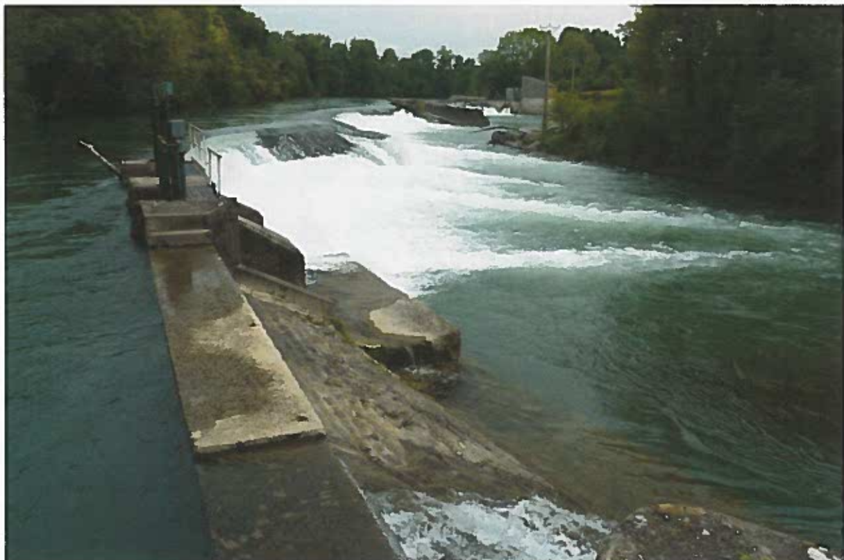
Vue du barrage Masseys depuis la passerelle de la prise d'eau de la centrale en rive droite – Photographie CE Mercier
