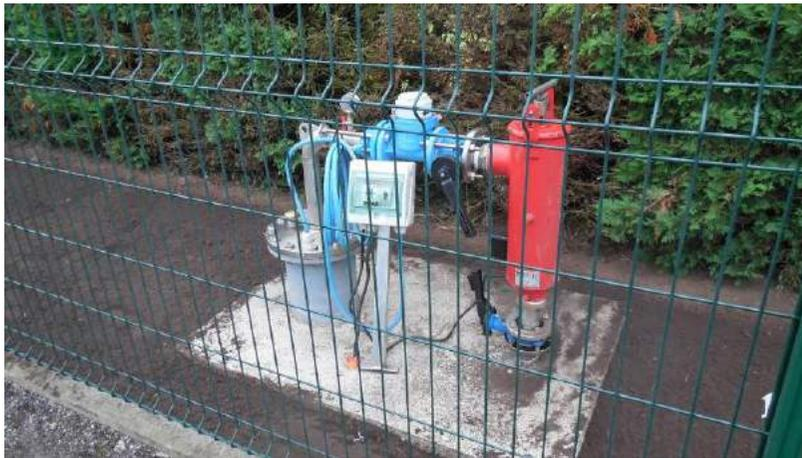
**Photographie de la nouvelle tête de puits du forage "foot", prise depuis le point 1 (cf. Plan ci-avant)**
