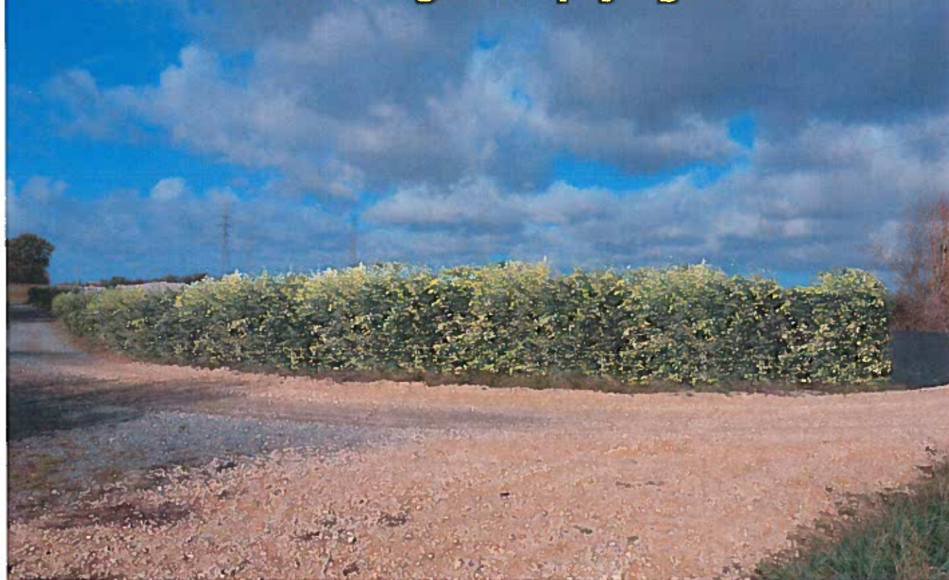
Poste SRD avec aménagement paysager
