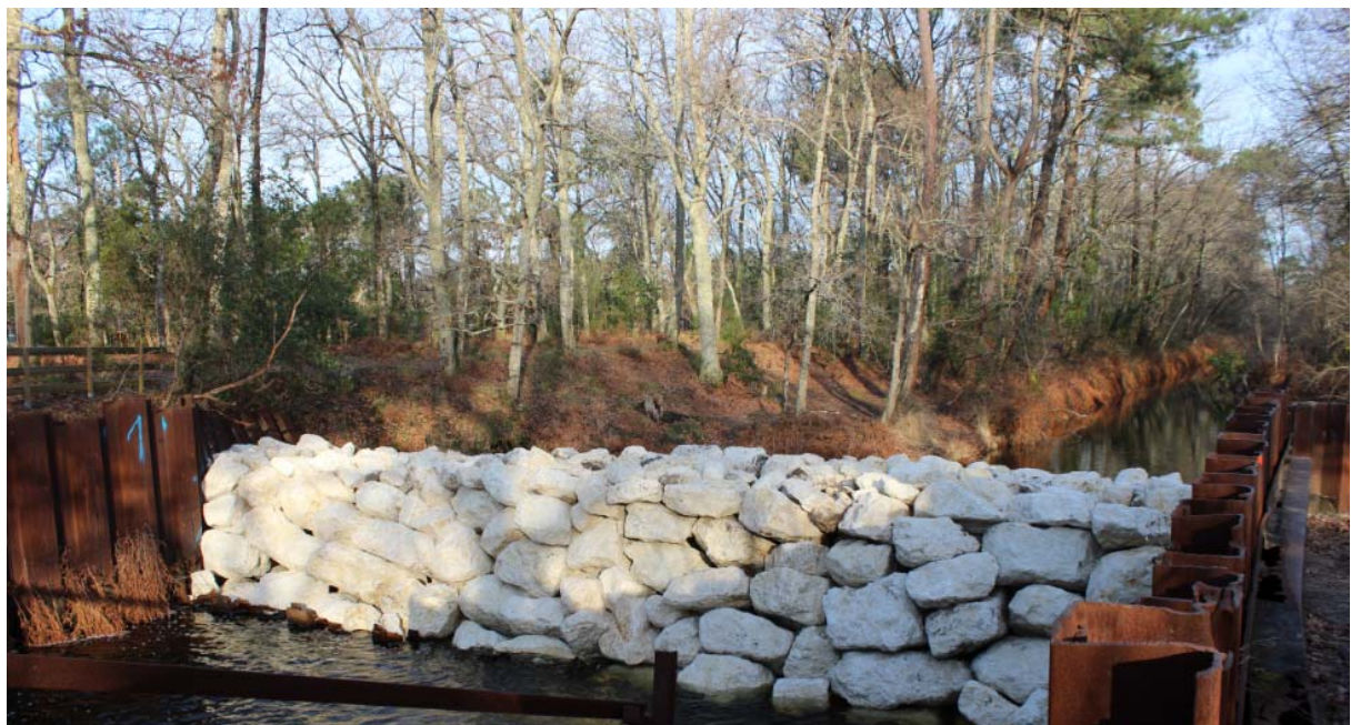
Vue de l'aval du seuil – Prise de vue : 10/02/2017
