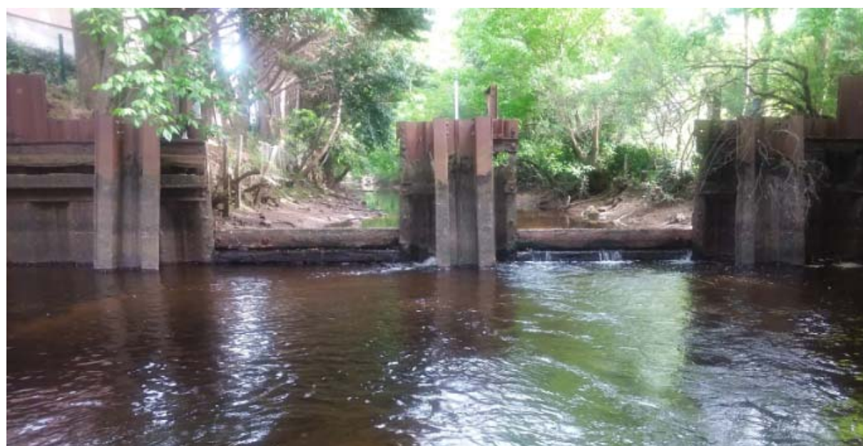
Vue de puis l'aval - Prise de vue : 15/05/2017
