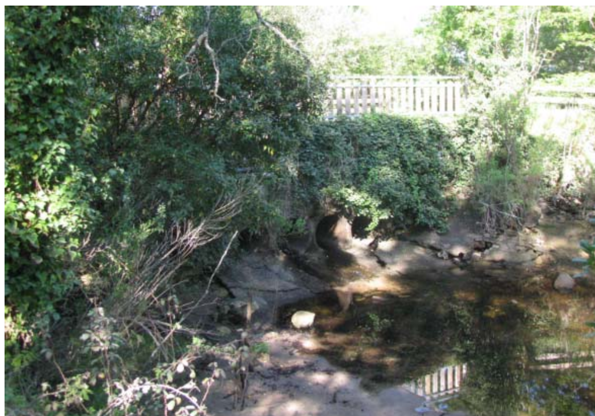
Vue depuis l'aval des 4 buses - Prise de vue : 18/04/2017
