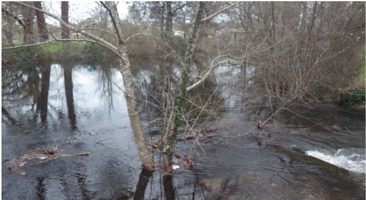
Amont du déversoir - Prise de vue : 12/02/2014
