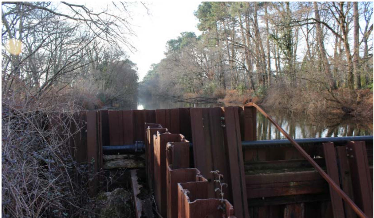
Vue de l'amont du seuil – Prise de vue : 10/02/2017
