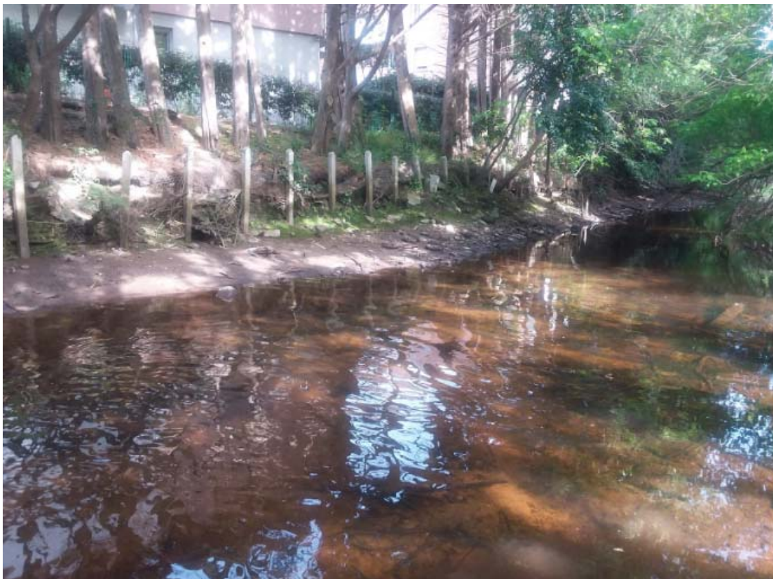
Vue de l'amont, rive droite - Prise de vue : 15/05/2017
