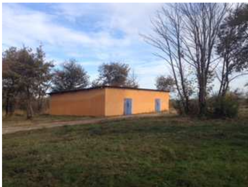
Vue de l'angle sud-ouest du bâtiment
