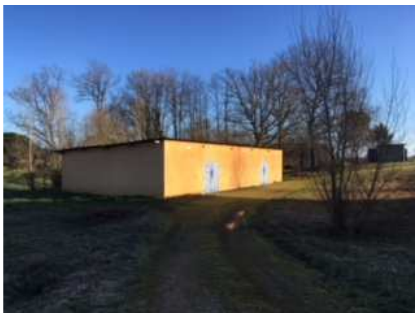
Vue de l'angle sud-ouest du bâtiment
