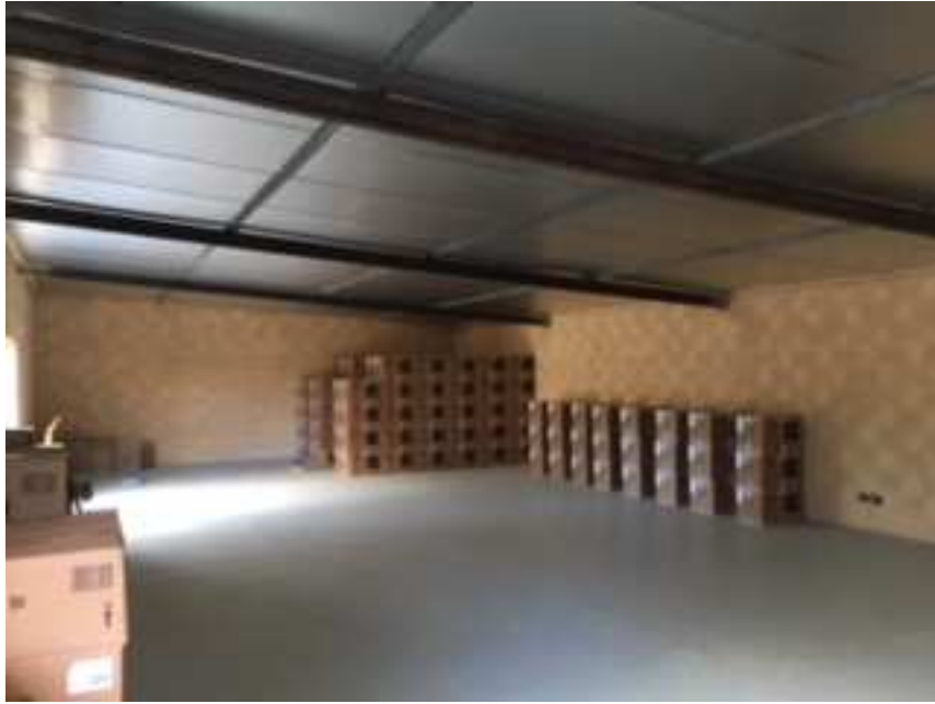
Intérieur du bâtiment D04 avec un stock de 2407 kg au 26/01/2018
