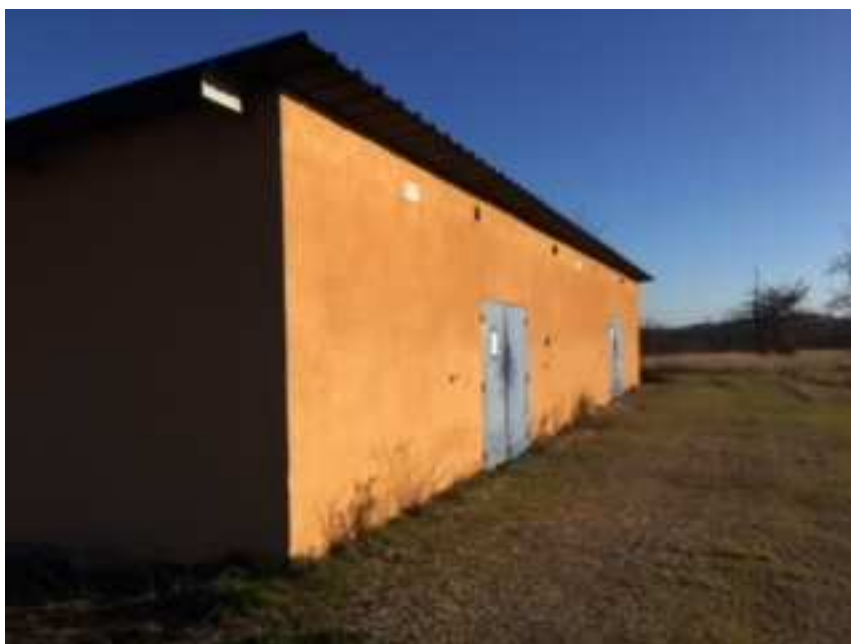
Vue de l'angle sud-ouest du bâtiment
