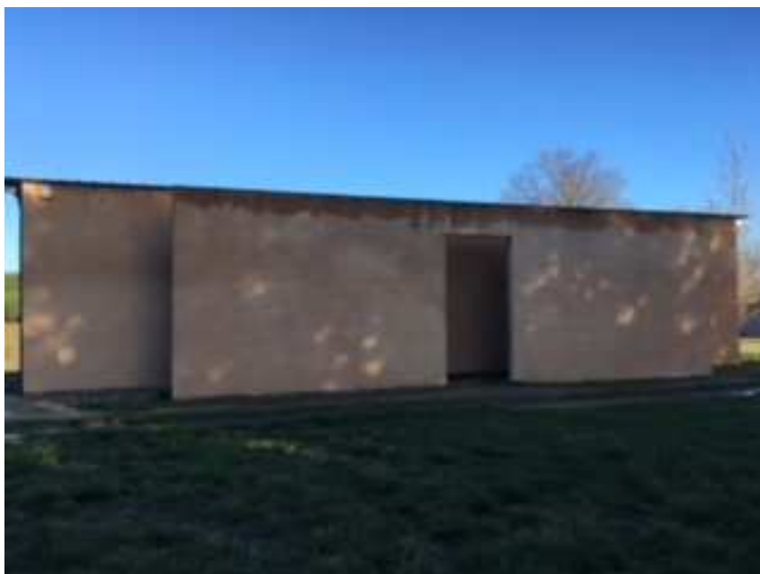
Vue de la façade sud du bâtiment
