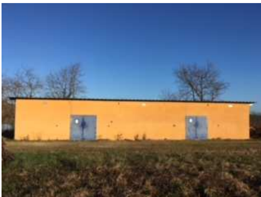
Vue de la façade sud du bâtiment
