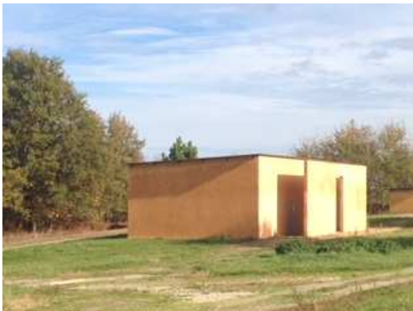
Vue de l'angle sud-ouest du bâtiment
