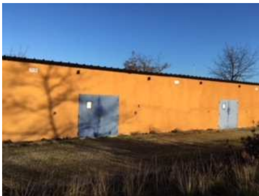
Vue de la façade sud du bâtiment
