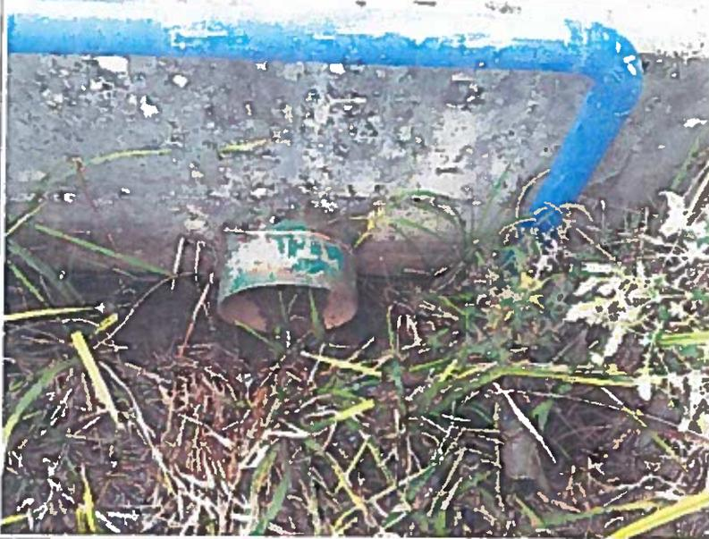
La vanne spécifique d'un diamètre 80mm est reliée à un tuyau souple qui se déverse dans le cours d'eau à l'aval. Ce système ne permet pas la mesure par le seuil triangulaire.
