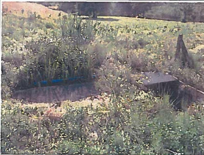
le canal est envahi par la végétation et il n'est pas équipé du seuil triangulaire. La mesure du débit est impossible.
