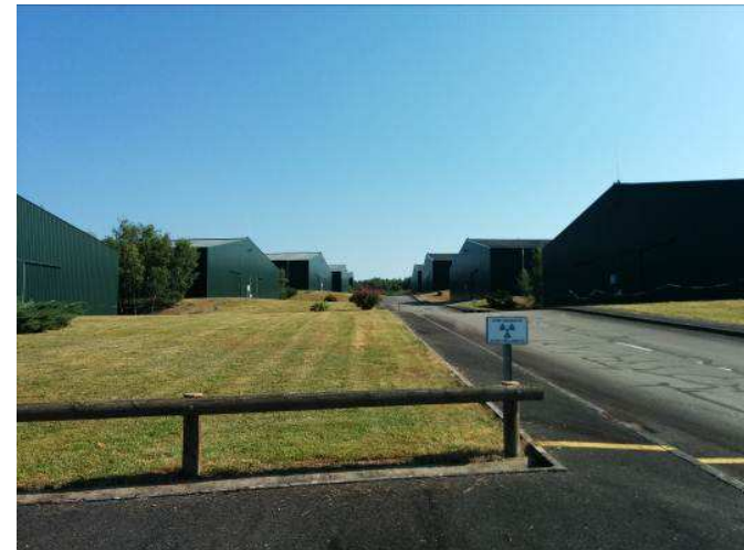
Photo 2 : vue rapprochée de l'installation depuis le côté sud [Octobre 2017]. Voir localisation cartographique sur l'annexe 4.
