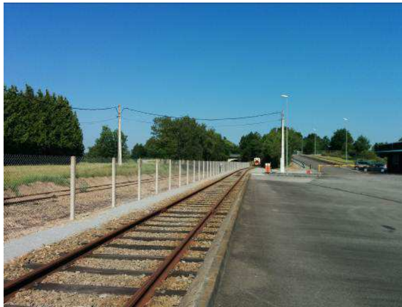
Figure 14 : Portion de l'aire de déchargement et de la voie ferrée
