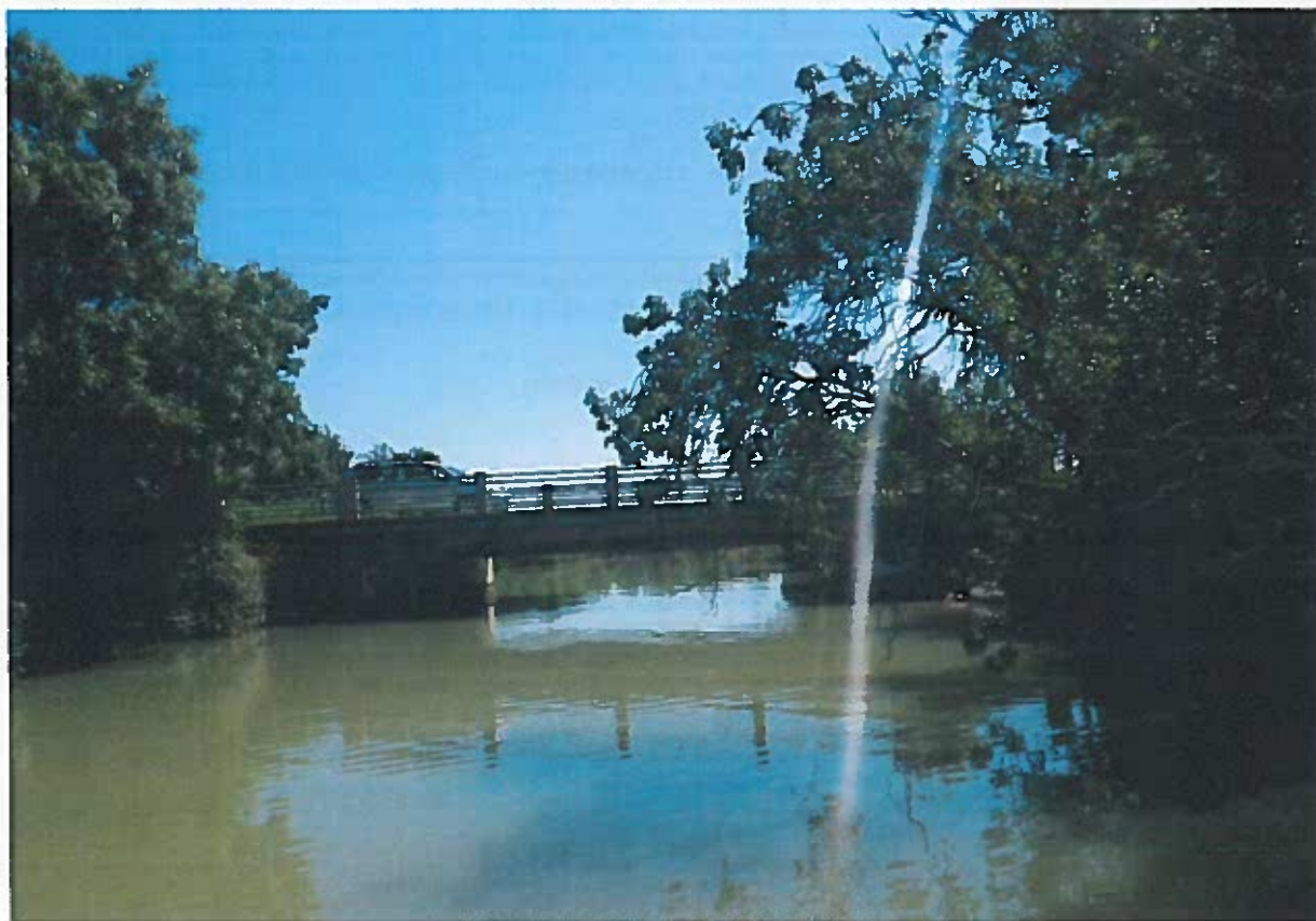
Figure 7 : Photo de l'aval
