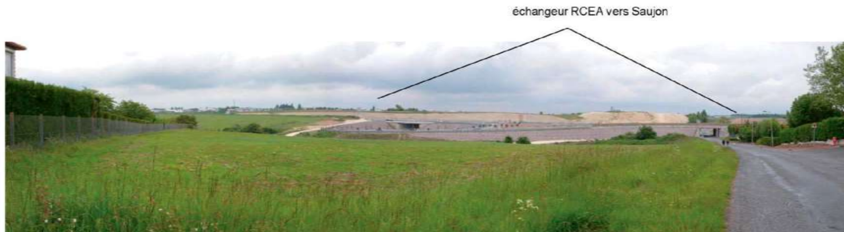
rue de Chermignac, vue vers le Sud
