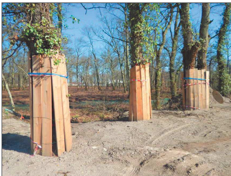
Figure 5 : Dispositif de protection des arbres remarquables sur chantier (Source : ENVOLIS)
