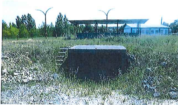
Dispositif de lancement de l'un des deux pas de tir du ball-trap (prise de vue vers le sud)
