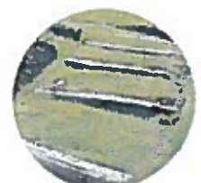
Détail 2 : traitement partiel des dénivelés naturels du terrain avec rondins de bois
