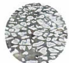
Détail 1 : plate-forme empierrée de l'entrée du site avec gros joints pour installation de la végétation
