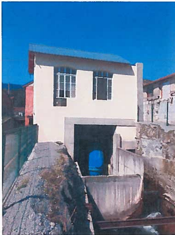
Centrale des Tanneries : vue de l'aval
