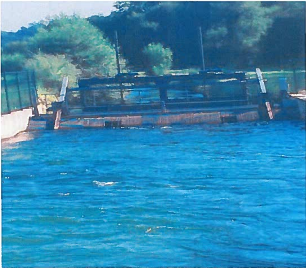
Prise d'eau ichtyocompatible du Canal d'Arudy
