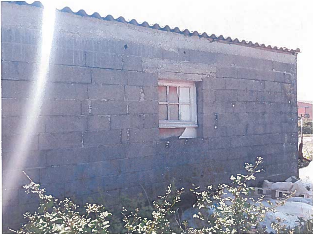
Façade Nord-Ouest objet de la rénovation
