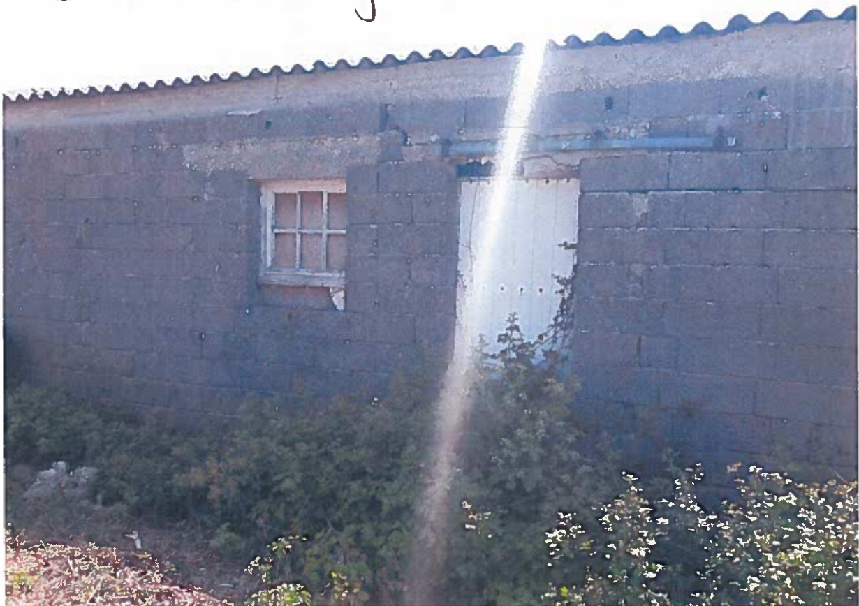
Façade Nord-Ouest objet de la rénovation
