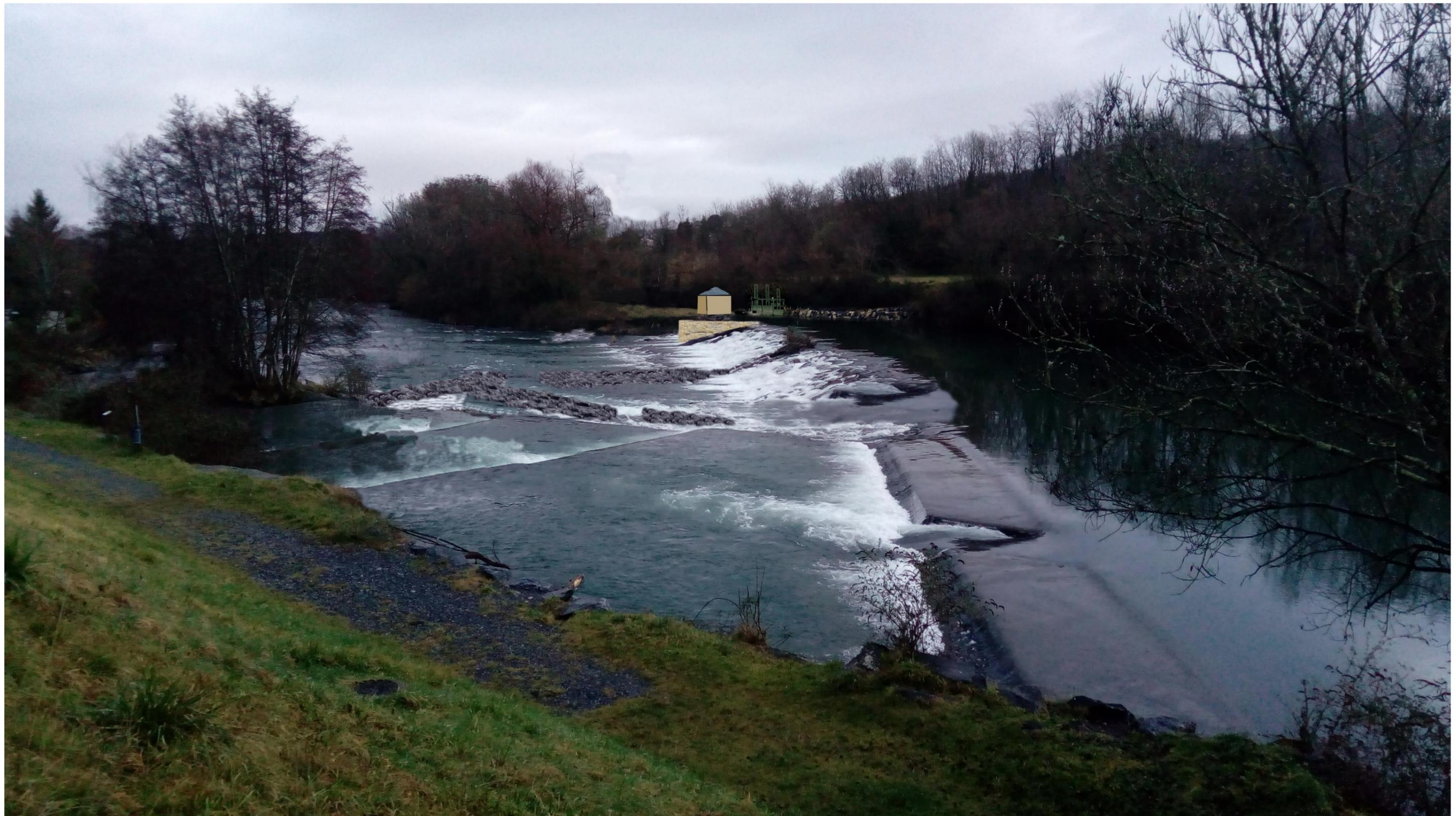
Les travaux consistent en l'ajout d'une échancrure au niveau du seuil ainsi que de bassins à l'aval de la passe à poissons existante. Un bassin sera de type maçonné comme ceux actuellement à l'amont, l'autre sera sous forme de prébarrage. AU fond, sera visible le bâtiment abritant la vis ainsi que le bajoyer béton latéral de la vis (pas de visuel direct de la vis depuis cette prise de vue).
