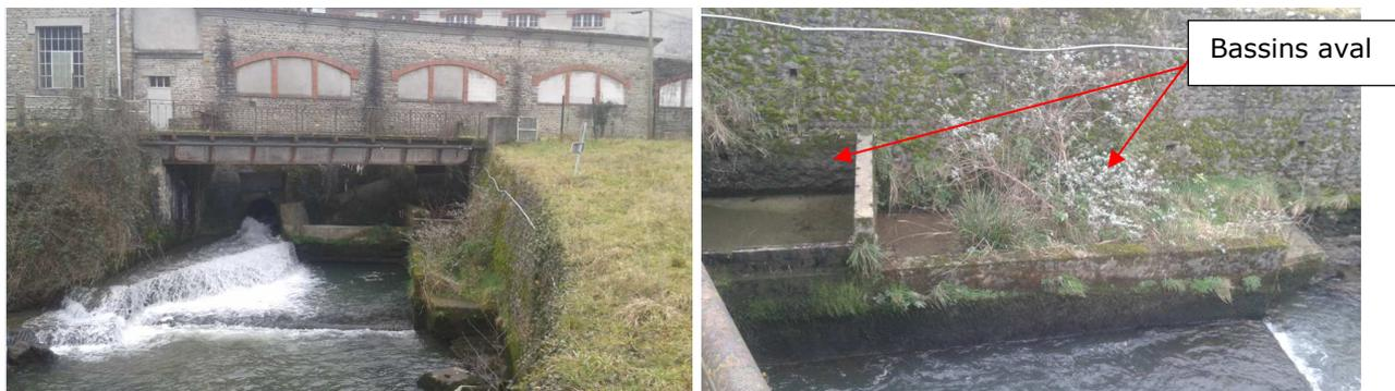
Figure 68: Vue bassins aval piégeant les poissons en cas de déclenchement centrale
