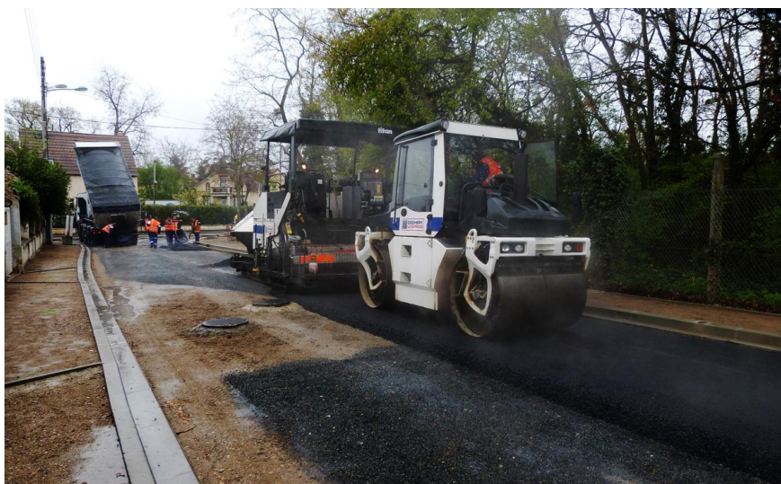
Atelier de réfection de voirie
