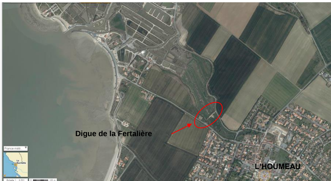
Figure 3: Localisation de la digue de la Fertalière à l'Houmeau
