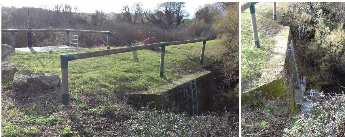
Photographies de l'ouvrage hydraulique côté aval
