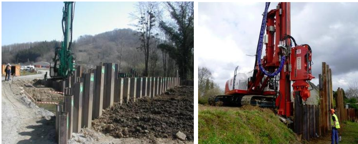
Atelier de vibrofonçage de palplanches
