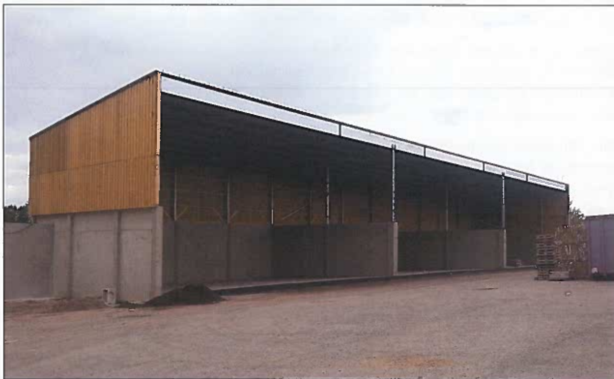
Auvent de stockage
