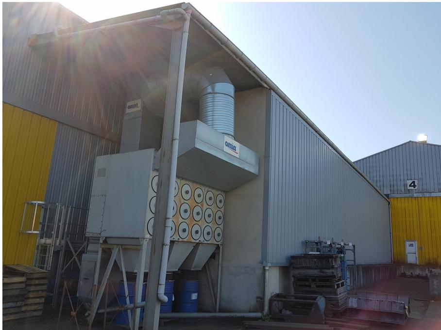
Système de dépolluissage de la cabine de grenaillage
