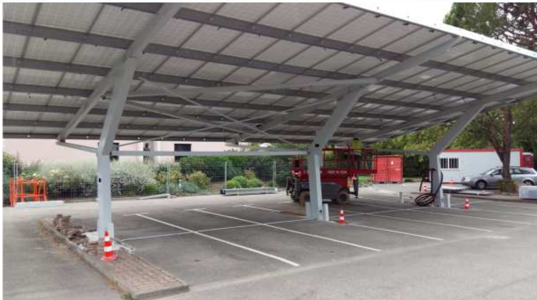
Exemple d'une charpente ombrière
