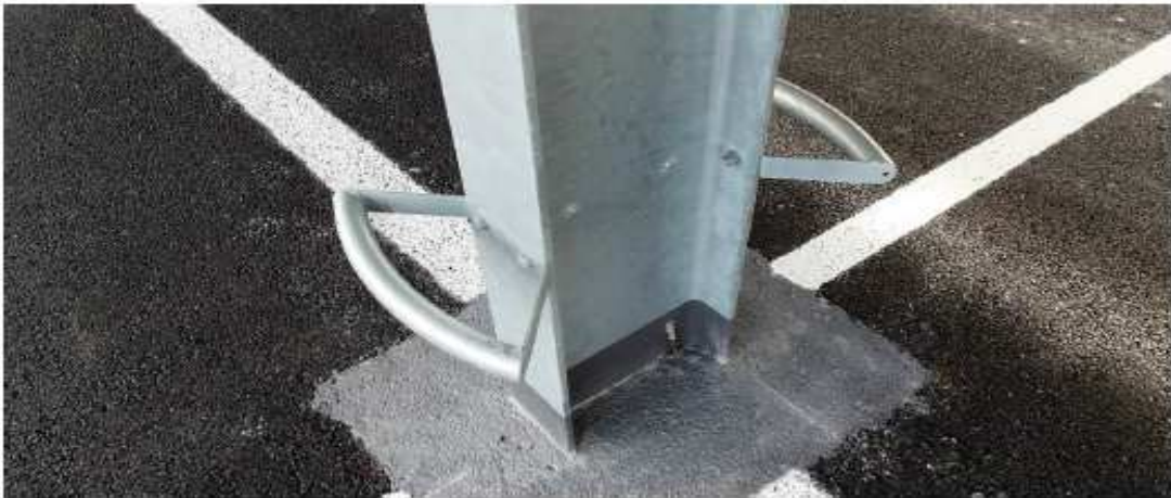
Exemple d'arceaux de protection
