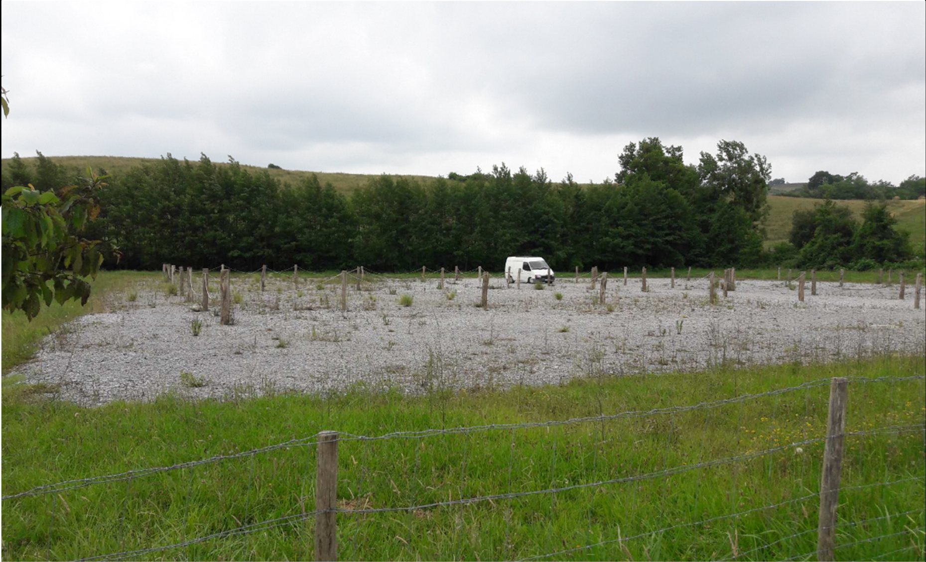
Photographie 4 : prise de vue dans l'environnement proche (date : 27 juin 2018)
