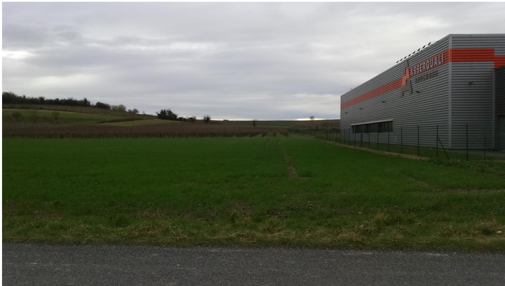
Photographie 2 : projet vu depuis la RD 148 – 1 er mars 2018
