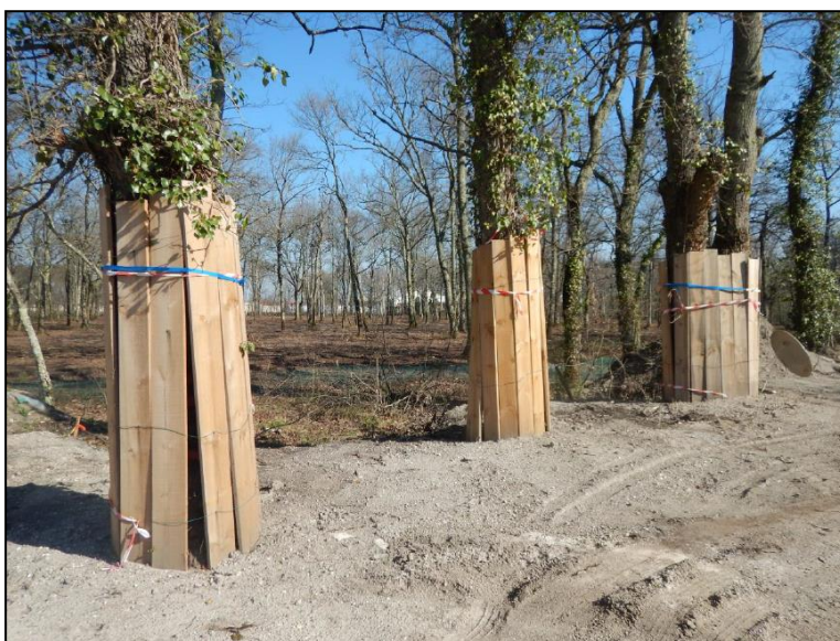
Figure 11 : Dispositif de protection des arbres remarquables sur chantier (Source : ENVOLIS)
