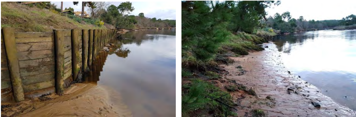
Figure 102 : Berge le long du profil G (partie amont à gauche et aval à droite).
