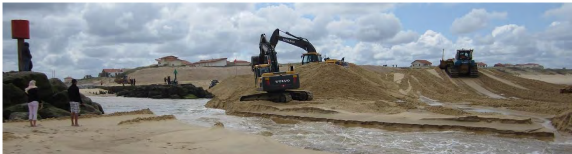
Figure 76: Opération de désensablement du débouché de 2015
