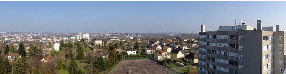
Immeuble rue Domnolet-Lafarge n°32 et terrain de sport
