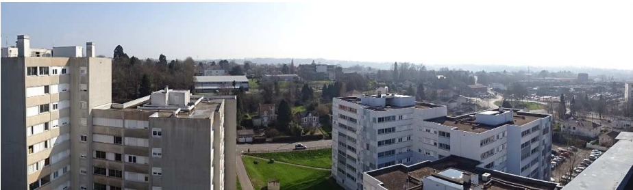
Immeubles rue Domnolet-Lafarge n°32-34
