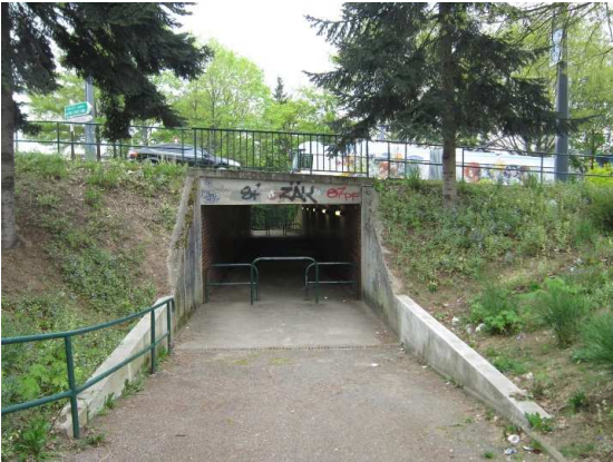
Passage souterrain avenue Pompidou Le projet prévoit sa condamnation et un aménagement aérien sécurisé.
