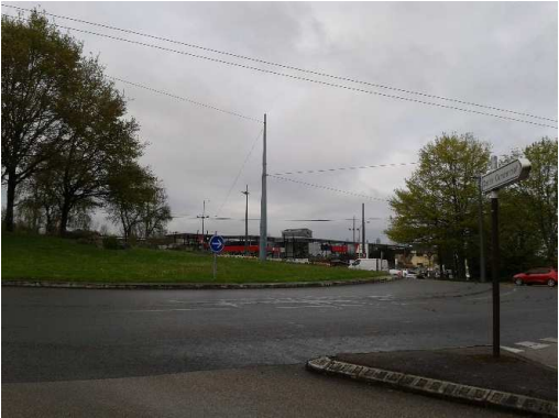
Place Queuille (vue depuis l'avenue Pompidou)
