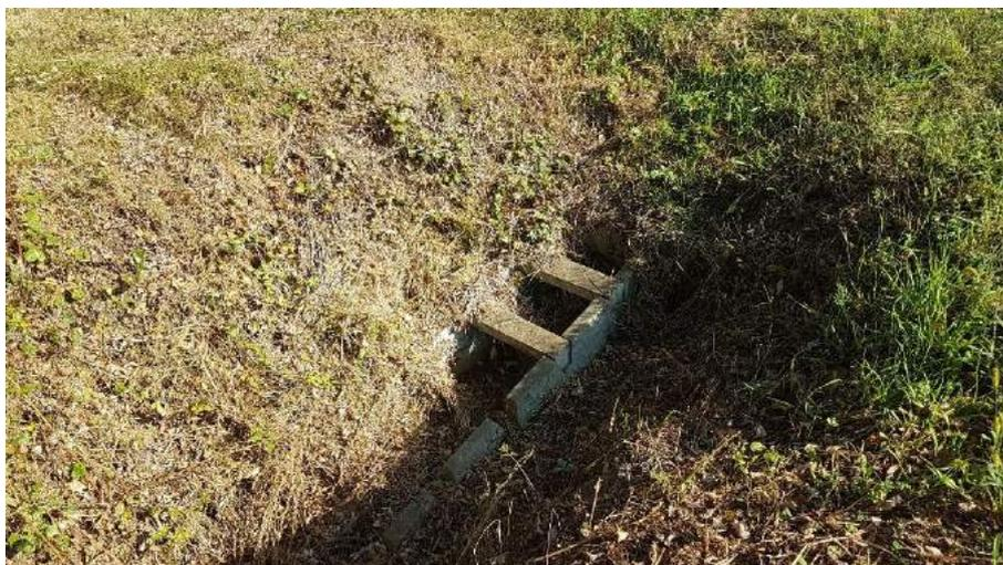
Le ruisseau traverse l'avenue des Iris à l'ouest à l'aide d'une buse, obstruée par des débris végétaux (résidus de fauche).
