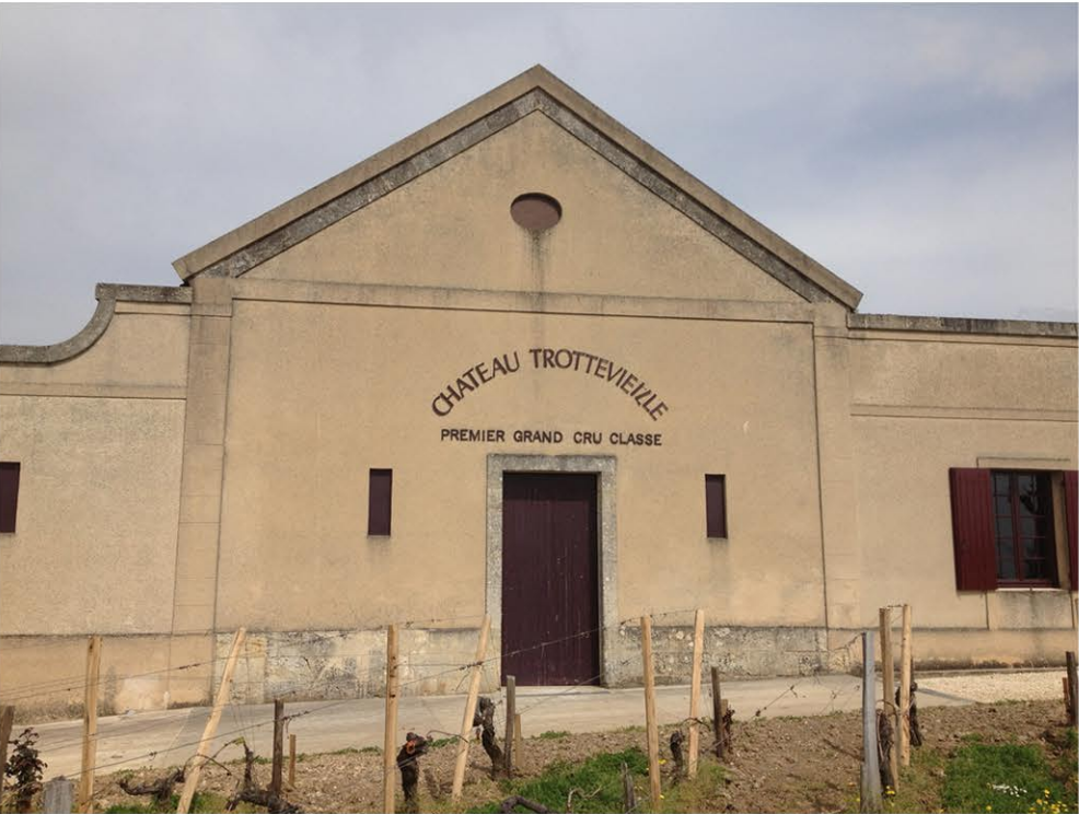
5. Photo façade Ouest
