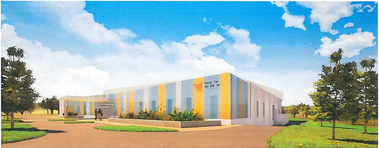
Vue sur le projet depuis l'entrée du site
