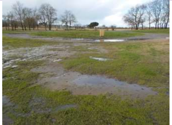
Zone de manoeuvre
