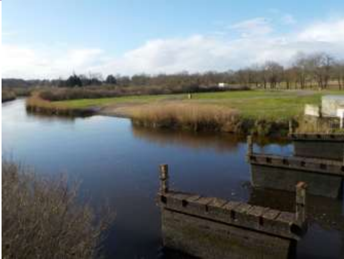
Vue du site depuis le pont
