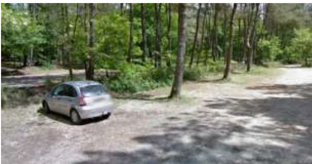
Exemple de parking en grave calcaire compactée
