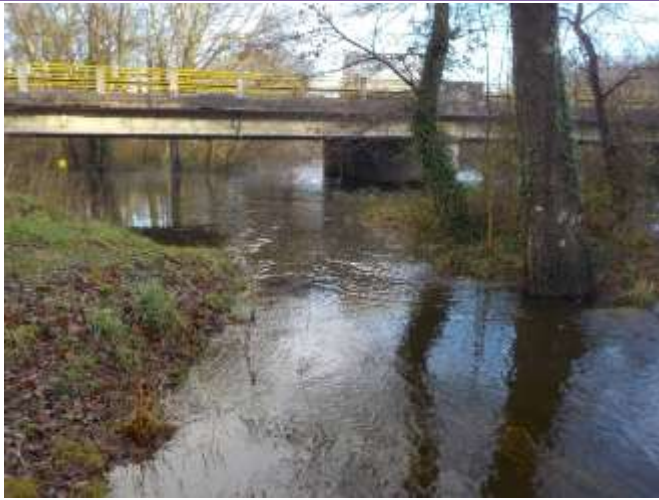
Vue du pont de Lamothe en crue
