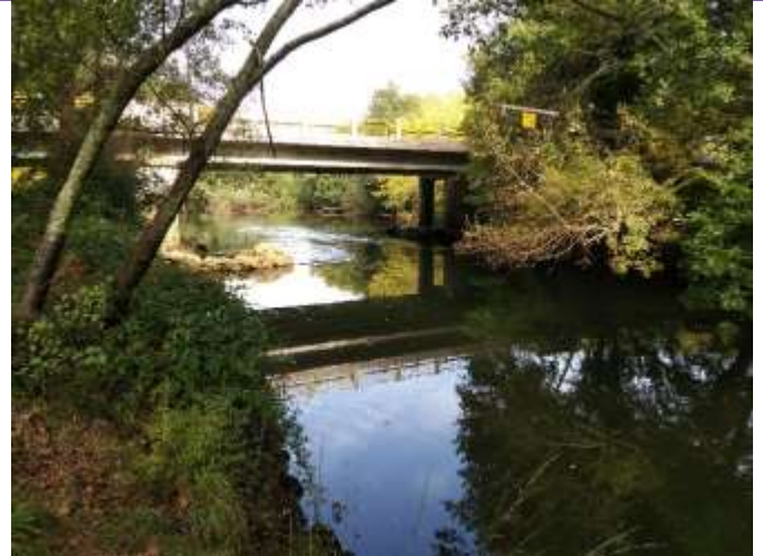
Vue du pont de Lamothe au module
