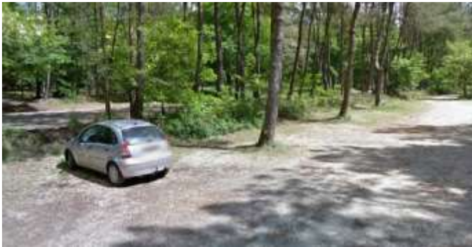
Exemple de parking en grave calcaire compactée
