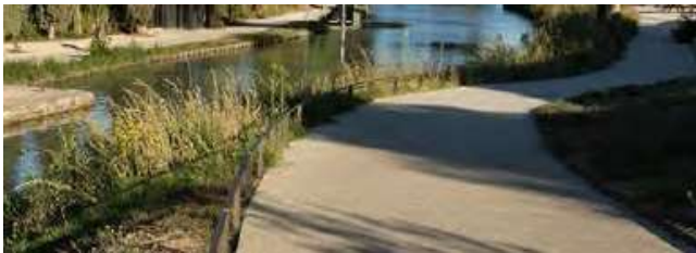
Exemple de cheminement en béton balayé
