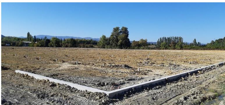
*Figure 10 : Exemple de fondations béton extérieures. Prise de vue Reden Solar.*
