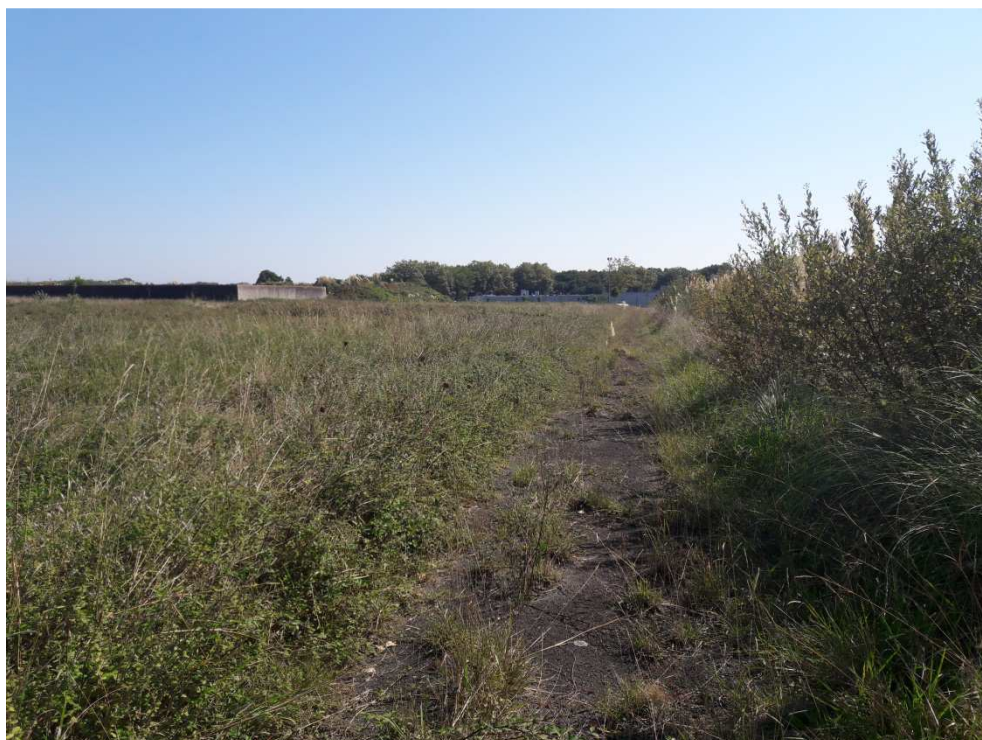
Photographie n° 3 : Vue sur la limite Sud de la plateforme (COLAS SO, 11/09/2018)
