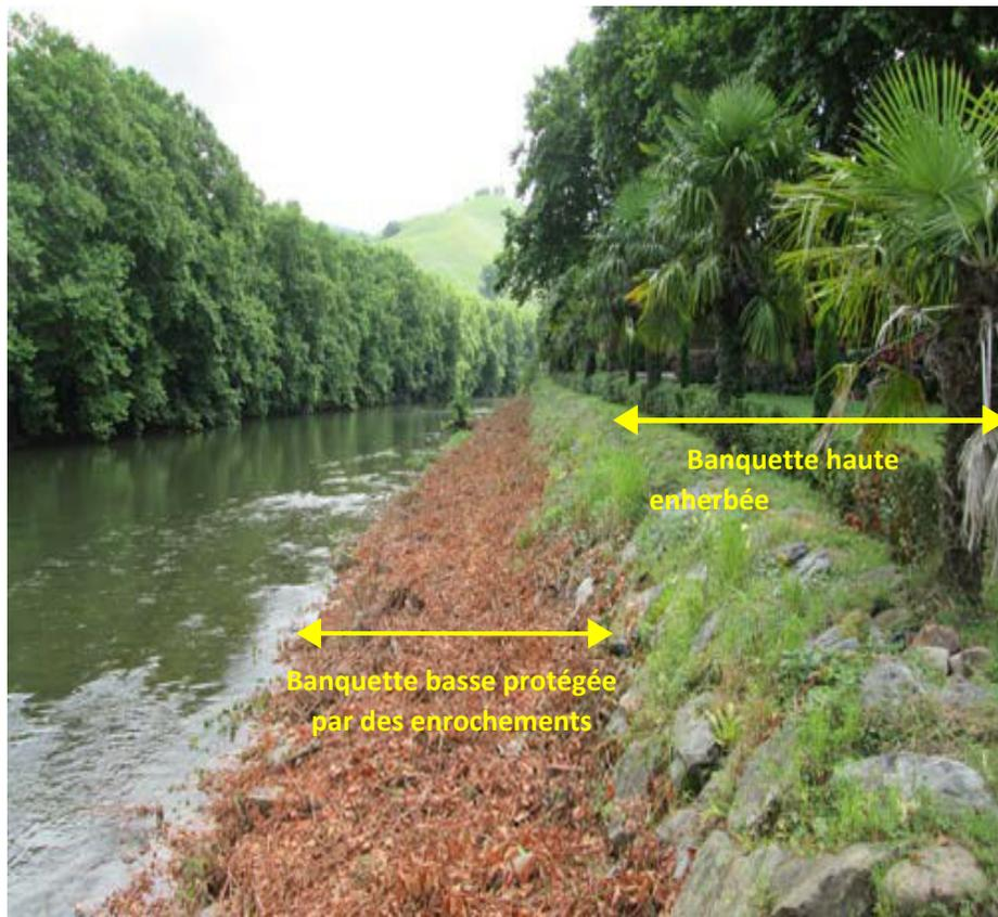
Les 90 premiers mètres en aval de la digue, la Nive est bordée par une banquette de 2 m de large environ. Environ 4 m en surplomb, une deuxième banquette enherbée sépare la rivière du mur de soutènement sur lequel s'appuie les thermes. La berge de la rivière, la banquette basse et le talus entre les deux banquettes sont protégés par des enrochements.
