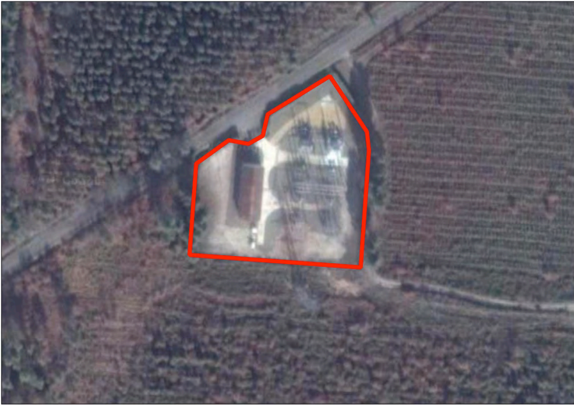
Vue aérienne du poste existant de GAREIN.
