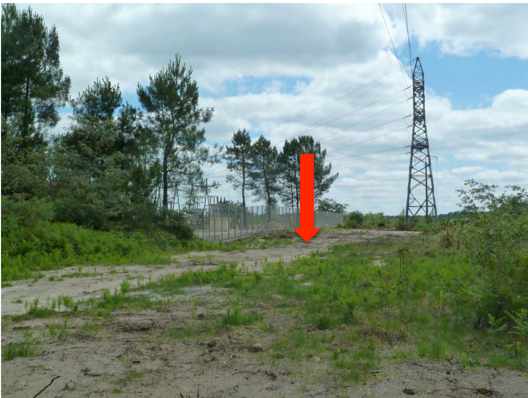
Vue n° 2 : Vue de la zone d'extension du poste de Garein (flèche rouge). Photo en direction est.
