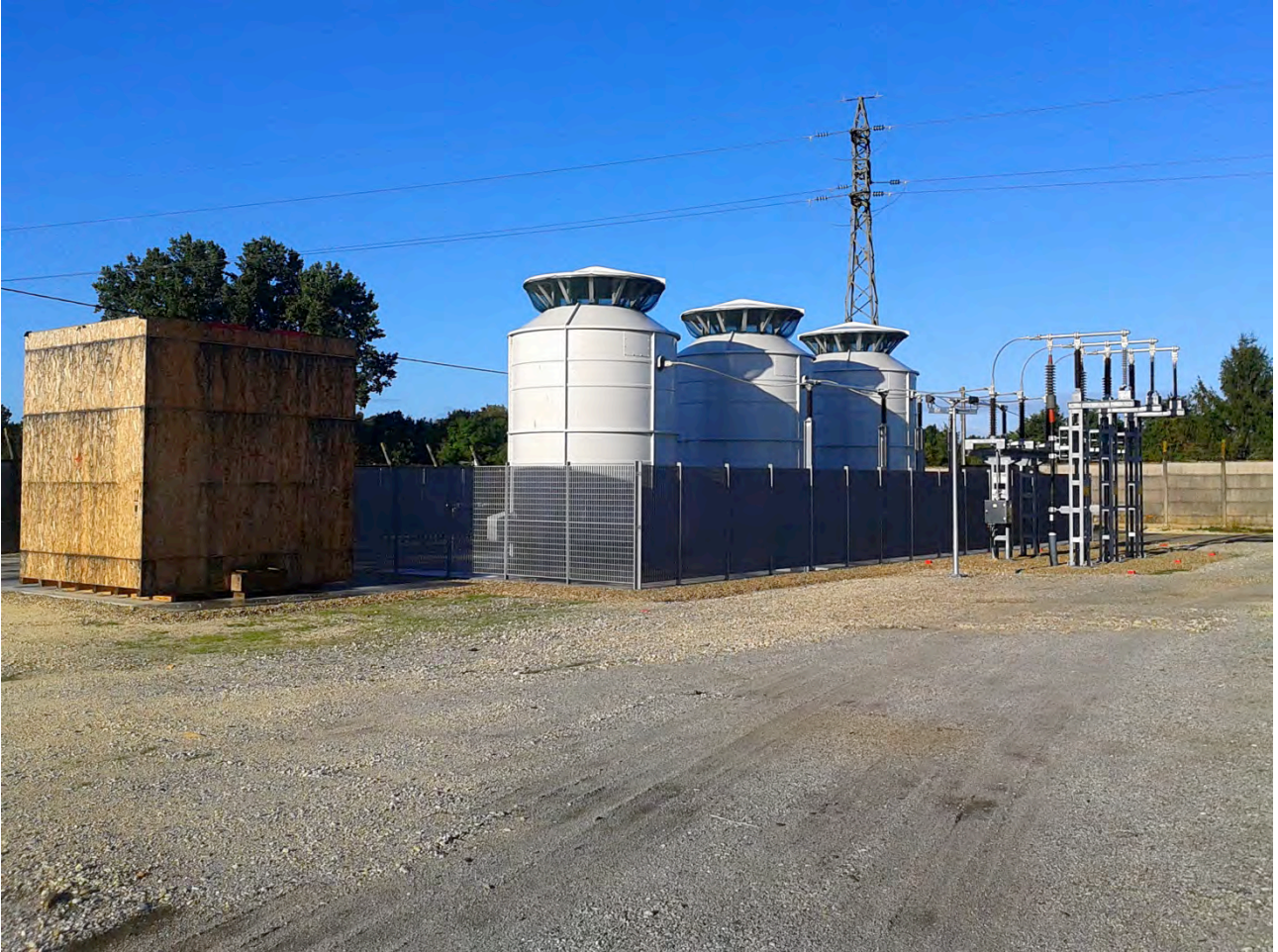
Exemple de Selfs tri-phasées.
