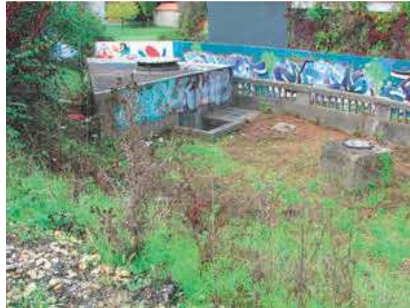
12 : Bâtiment au droit du talus Nord
