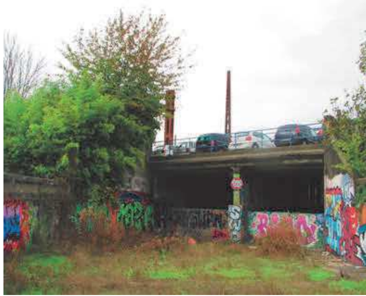
10 : Vue depuis l'ancienne voie d'accès Sud
