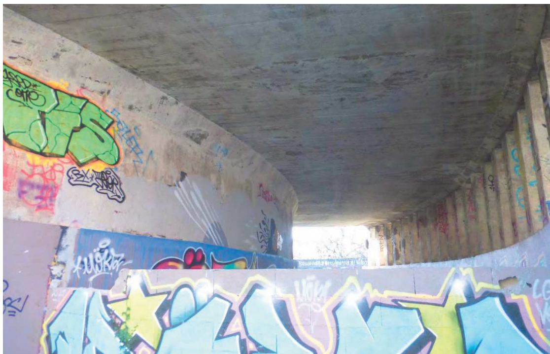
Figure 8 : Vue du souterrain de l'ancienne gare. Son plafond lisse sans anfractuosit   n'est pas attractif pour les chauves-souris (Photos source Simethis)
